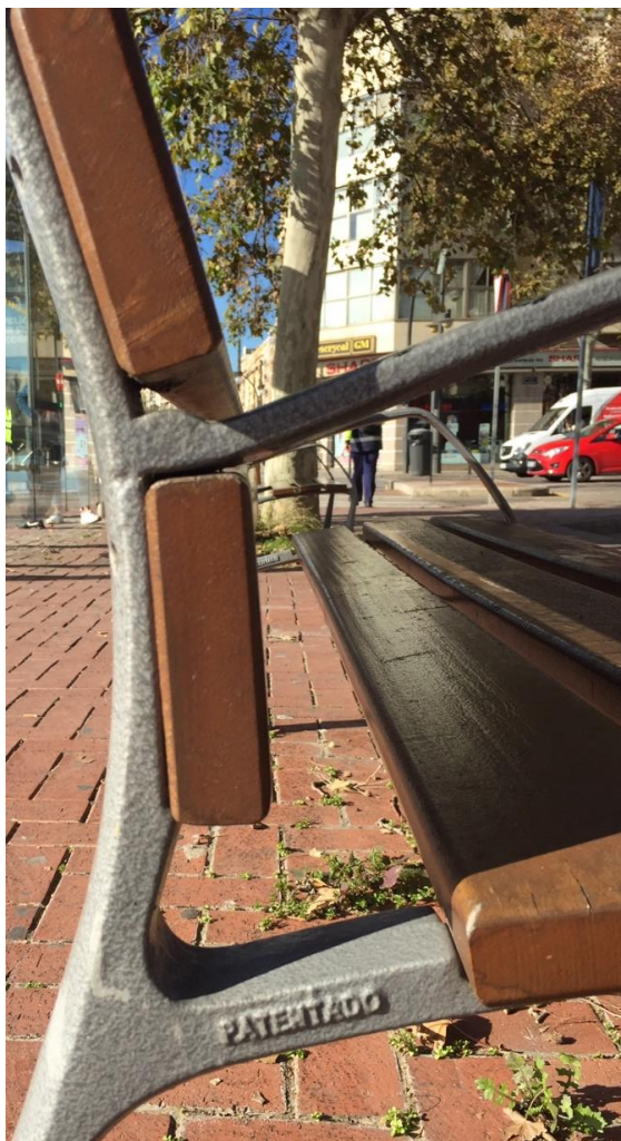
Imagen 3. Banco en madera y fundición de acero.
