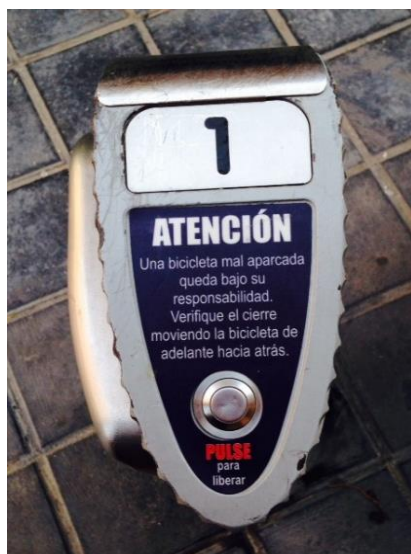
Imagen 6. Detalles del elemento de anclaje de las bicicletas de uso compartido. Fuente: Imágenes propias
