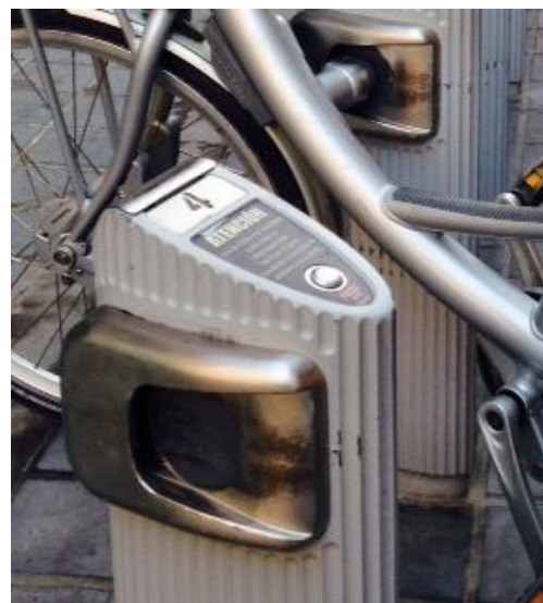
Imagen 6. Detalles del elemento de anclaje de las bicicletas de uso compartido. Fuente: Imágenes propias
