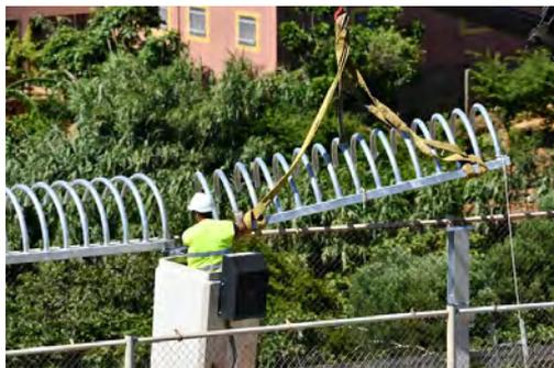
Figura 82. Fotografía del periódico *AS* en la que se muestra a un operario instalando el nuevo sistema de peines en la valla de Ceuta.
