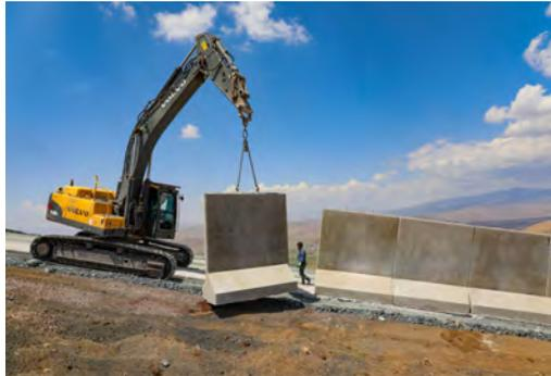
Figura 99. Fotografía difundida por la Agencia Anadolu en la que se muestra la forma en la que los operarios construyen el muro.
