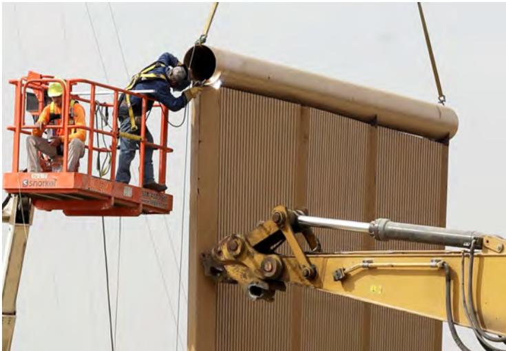
Figura 53. Fotografía de Gregory Bull tomada el 19 de octubre de 2017. En ella observamos a un equipo de soldadores uniendo dos partes del prototipo diseñado por W. G. Gates & Sons Construction Co.
