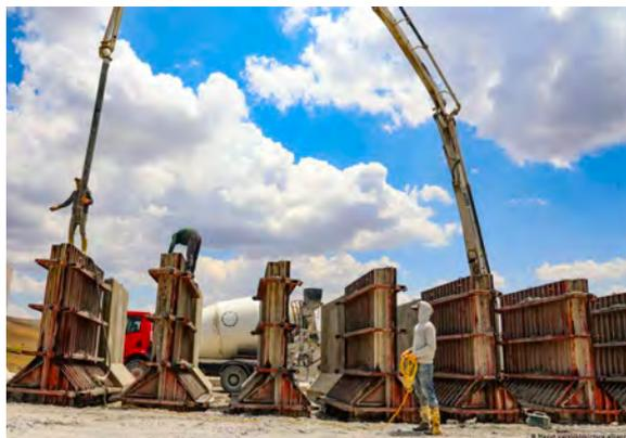
Figura 103. Fotografía de la Agencia Anadolu de los moldes usados para la construcción del muro.
