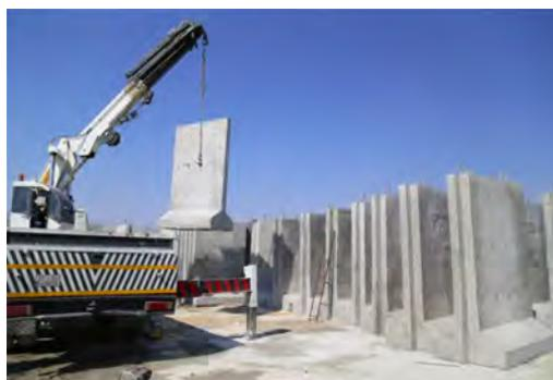
Figura 100. Fotografía publicada en el año 2015 por la agencia de prensa del gobierno turco Anadolu. En ella se observan los materiales y técnicas usadas en la construcción del muro.
