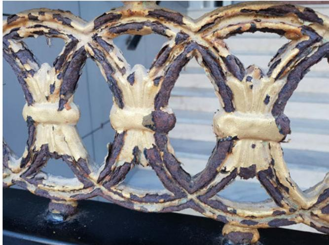
**Fig. 1 Efecto de la oxidación en una reja de hierro en primera línea del mar. 2022**
