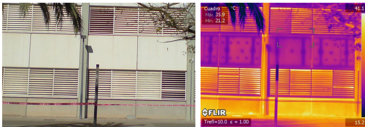
Figura 1. Ejemplo de visualización de estructura interior de aplacado de hormigón armado con termografía infrarroja
