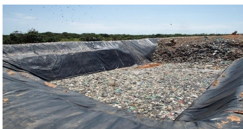
(a) Relleno sanitario controlado
