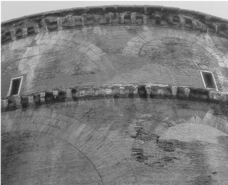
figura 10: Panteón de Roma. Detalle del muro externo.
