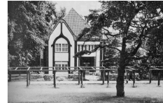
figura 8: casa de Peter Behrens en Darmstadt. 1900
