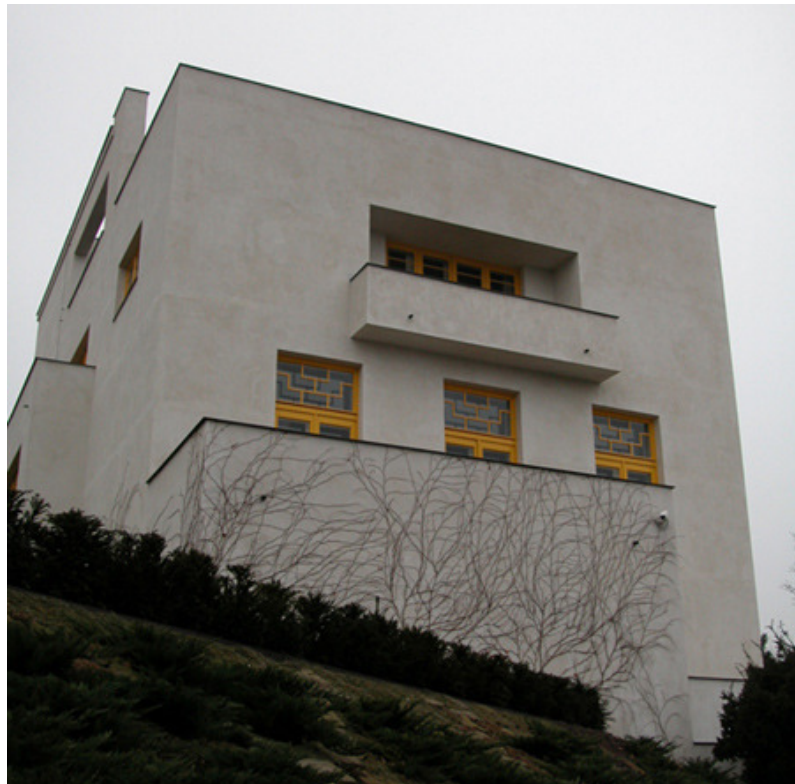
figura 26: Villa Müller. Vista actual de la fachada principal
