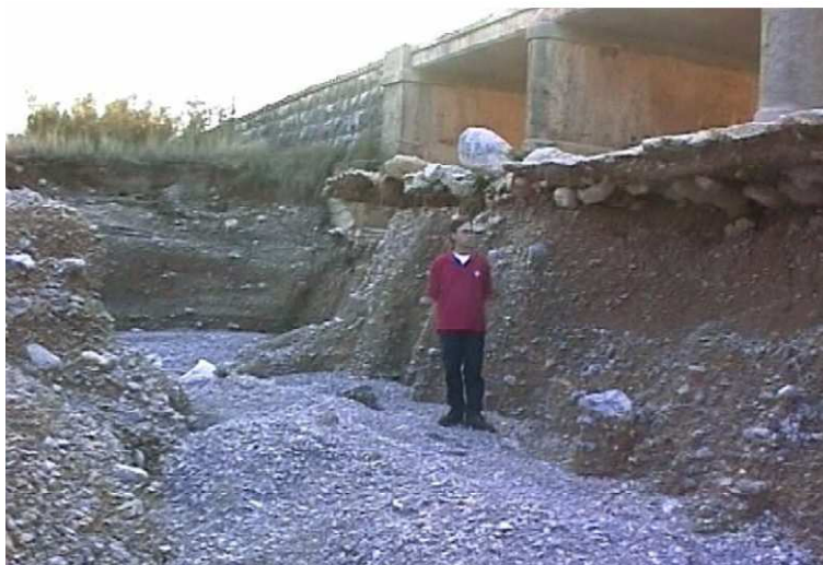
Figura 1.3. Fosa de erosión local aguas abajo del puente Xert sobre la Rambla Cervera (Castellón)
