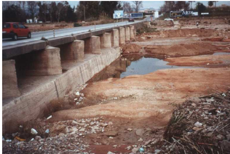
Figura 1.4. Puente de Canet sobre el río Palancia (Valencia)
