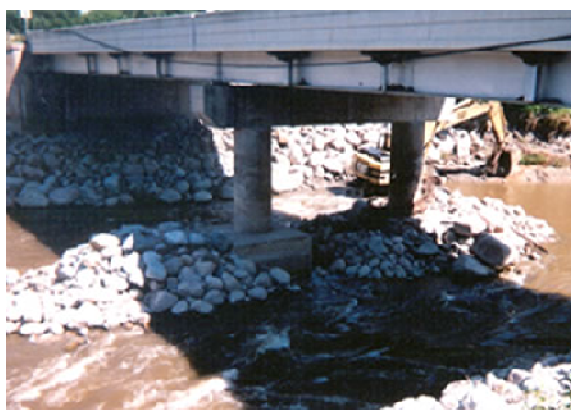
Figura 2.16. Ejemplos de protección del lecho en puentes en cauces
