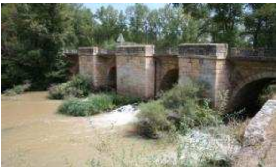
Figura 1.2. Erosión aguas abajo de un puente medieval protegido con sillares de grandes dimensiones. Izquierda: Vista general; derecha: detalle.
