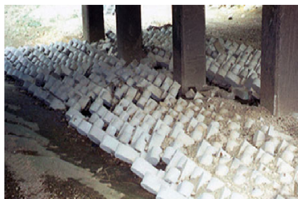
Figura 2.16. Ejemplos de protección del lecho en puentes en cauces
