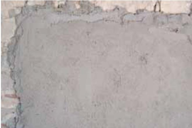
**Fig. 134.** La superficie se nivela con la llana. (Fotografía de la autora)
