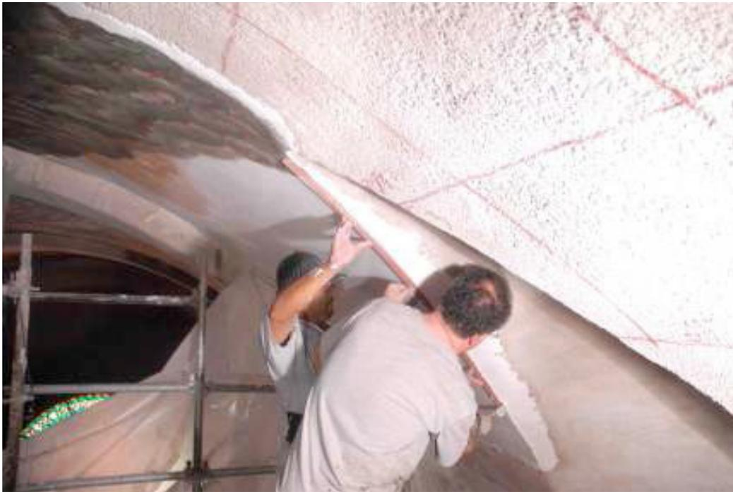
**Fig 127.** Delimitando mediante un listón los límites de la “jornada”. Obsérvese el trazado previo de las secciones en las que se divide el soporte mural y que pueden integrarse más de una en la misma jornada. Fotografía de Natalia Quílez
