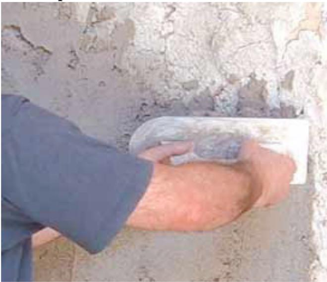
**Fig. 132.** *Enfoscado: el mortero es lanzado con la paleta y se deja la superficie rugosa. (Fotografía de la autora)*
