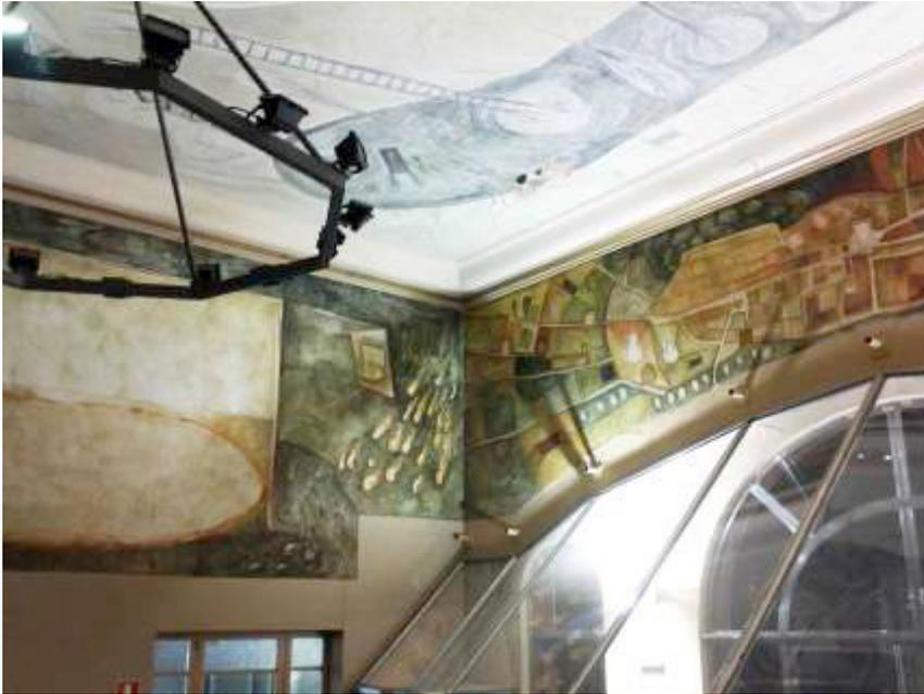
**Fig 4.** Vistas parciales de “La calle” y “La Escena”. En las pinturas del techo, ejecutadas con una técnica acrílica, pueden apreciarse importantes desprendimientos de pintura en forma de desconchados.
