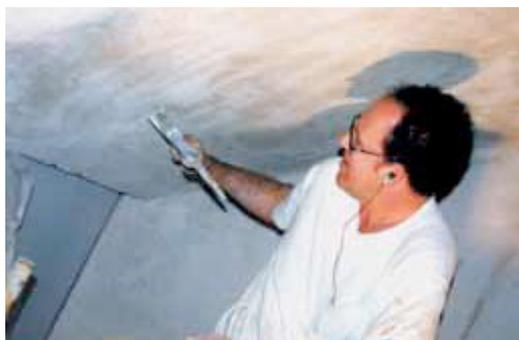
**Fig. 130.** Acción de raspar y picar el muro para asegurar la adherencia. (Fotografía de J. Minguell)
