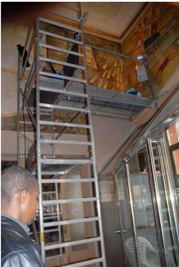
**Fig 10.** Sistema de andamios modulares e iluminación cruzada indirecta
