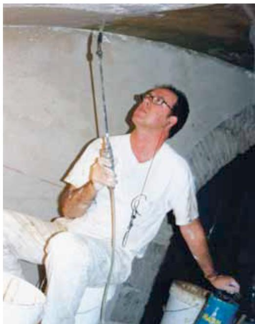
**Fig. 131.** Acción de mojar el muro con una bomba manual. (Fotografía de J. Minguell)
