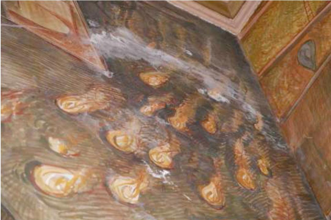
**Fig 9.** Agrietamientos y fisuras producidas por las eflorescencias salinas
