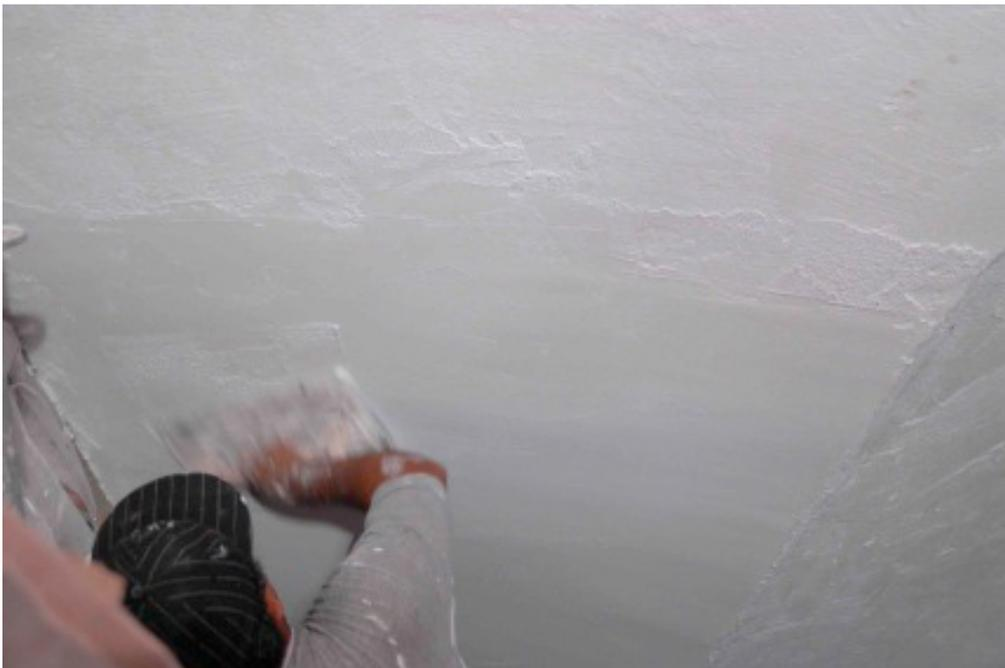
**Fig 126** *El albañil procede a la aplicación de la última capa de mortero previa a la inmediata ejecución pictórica: “intonaco o enlucido” . Fotografía de Natalia Quílez.*
