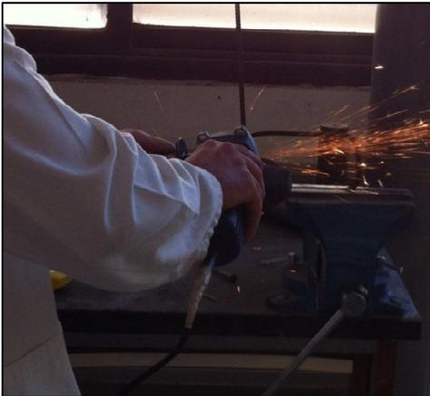
Fotografía 9.- Corte de las armaduras transversales
