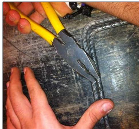
Fotografías 13 y 14.- Montaje de la ferralla
