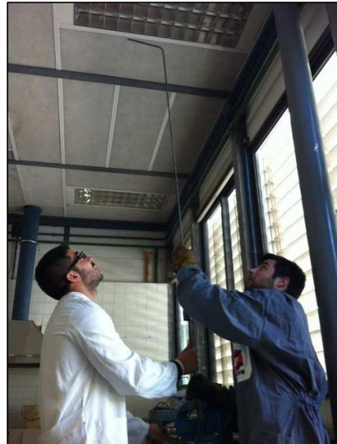
*Fotografías 7 y 8.- Proceso de doblado de las armaduras longitudinales para la realización de las patillas*
