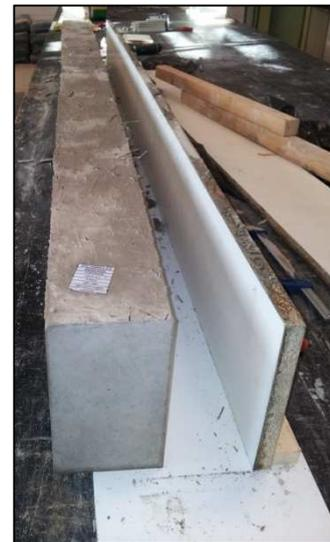
Fotografías 40 y 41.- Desencofrado de la viga
