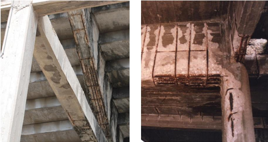
**Figs. 1.1a y 1.1b.** Estructuras expuestas a ambientes de corrosión. España.
