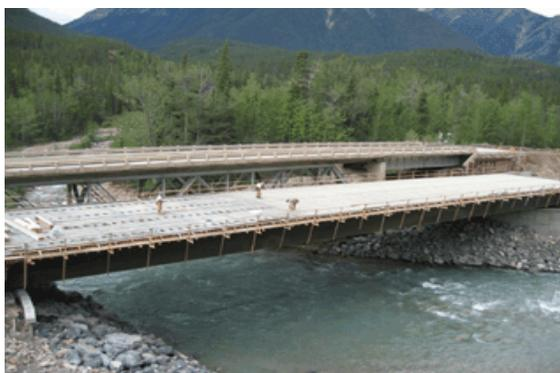
**Fig. 1.2.** Puente diseñado con armado de FRP, Canadá.
