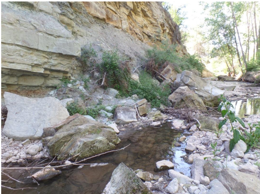
Figura 4.3. Desprendimientos a pie de ladera
