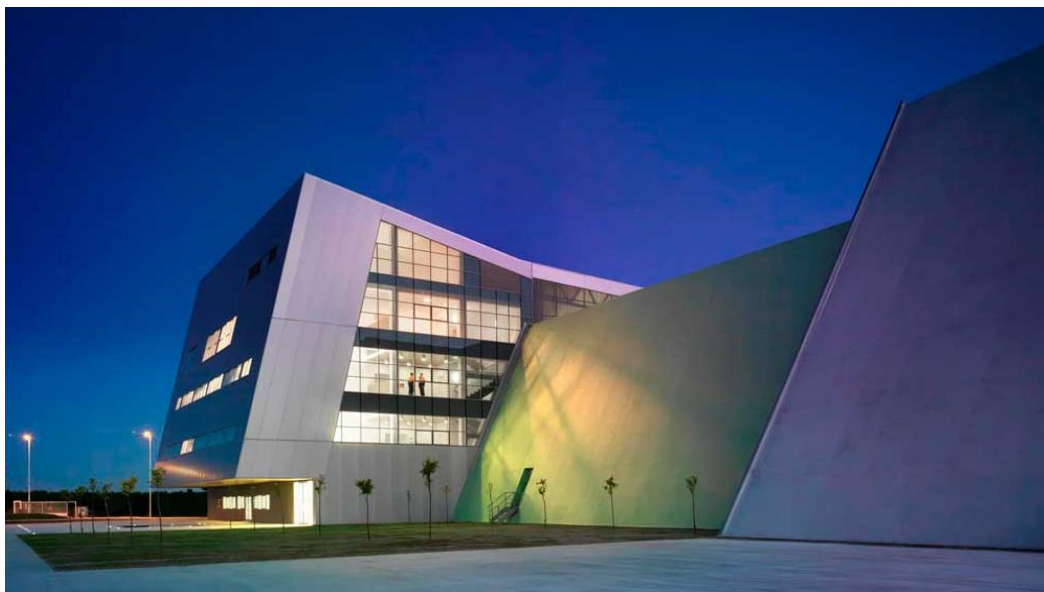
Figura 12.4.-Edificio de control de accesos Fuente: www.uteloshornillos.es
