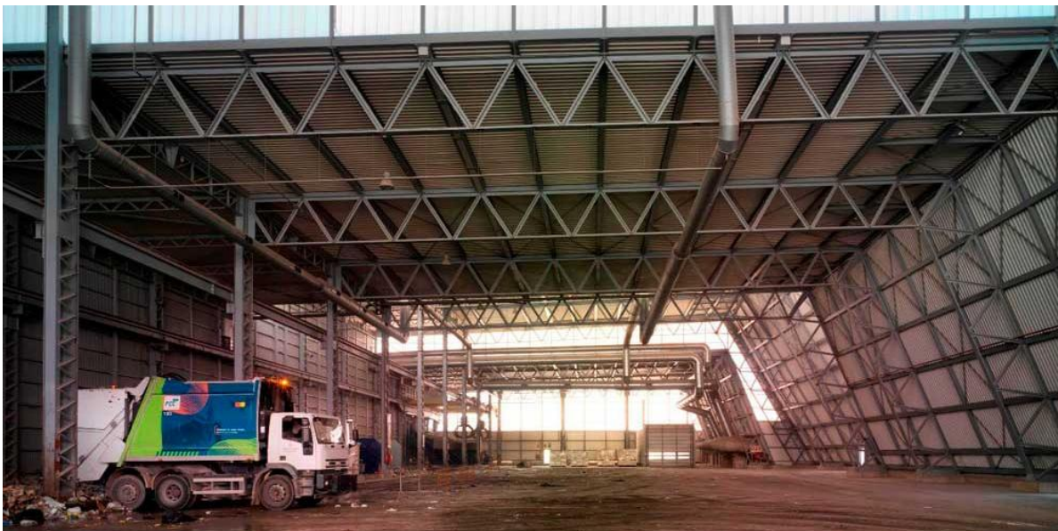
Figura 12.8 módulo de recepción y almacenamiento
