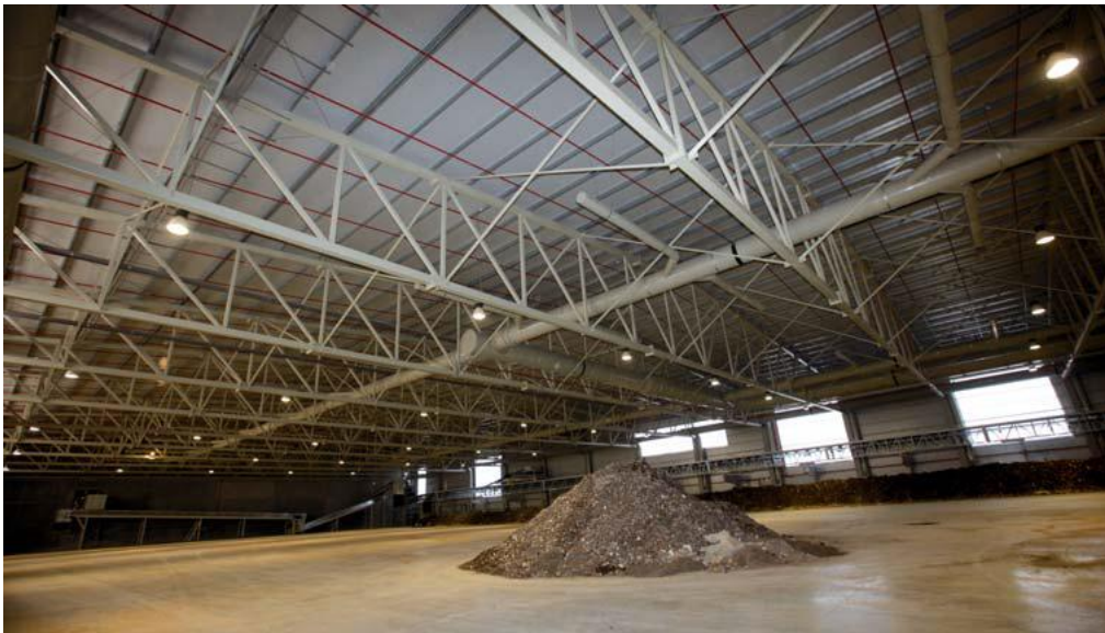
Figura 12.18.-Módulo de maduración de a fracción orgánica Fuente: www.retema.es
