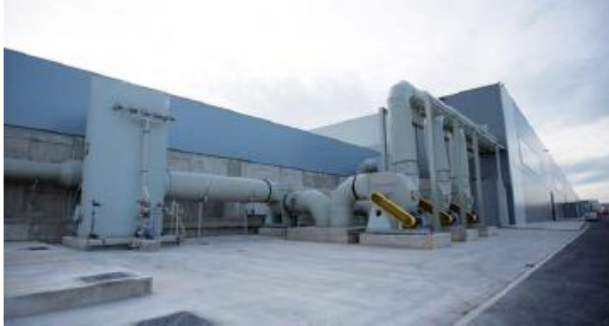
Figura 12.19.- Depuración del aire en los biofiltros Fuente: www.retema.es
