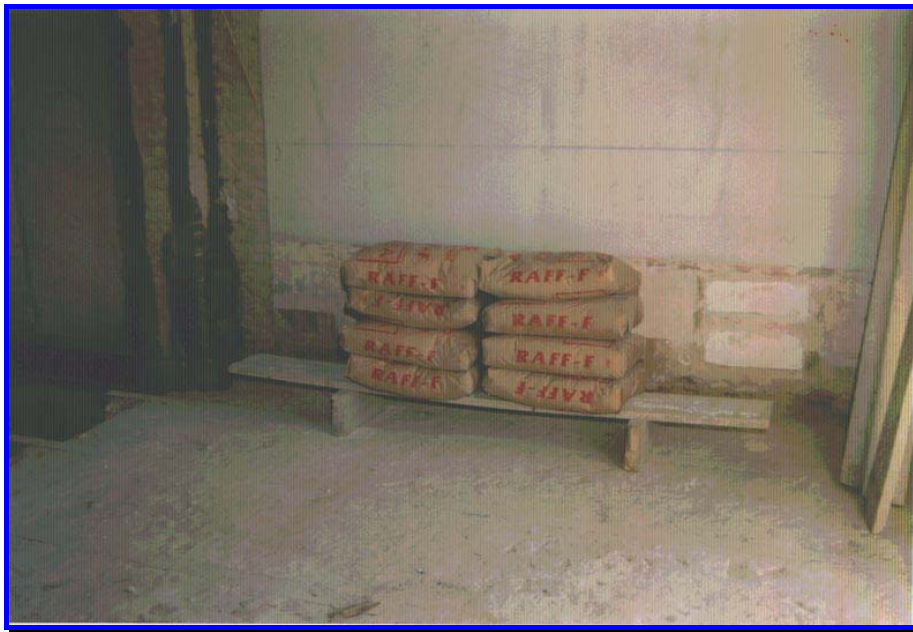
Fig. 4.39 Viguetas sin refuerzo en el escalón de carga de 200 Kp. , forjado n°4
