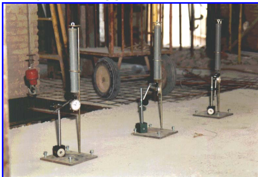
Fig. 4.31 Equipos de medida situados sobre trípodes.
