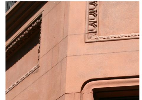
Fig.115. Detalle de la piedra brownstone en una fachada de una vivienda en Park Slope (Brooklyn), donde se aprecia la textura granular de la piedra, septiembre 2013
