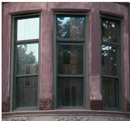
Fig.126. Ventanas con contraventana de madera por su parte interior, 57 Halsey Street, septiembre 2013
