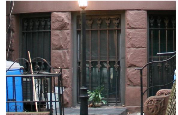
Fig.133. Rejería de las ventanas del semisótano, 74 Halsey Street
