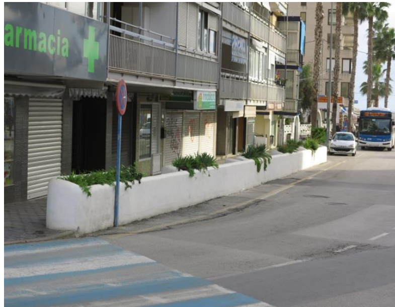
Fig. 9. Muro de resguardo construido aguas abajo del cruce entre el barranco de La Cala y la Av. Marina Baixa. FUEENTE: elaboración propia.
