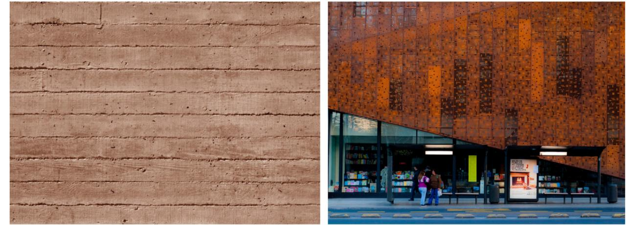
Diseñadas las perforaciones expresamente para el proyecto, los paneles dibujaran en el interior de este gran espacio de cubrición de los depósitos pretéritos una malla de luz cambiante gracias a los diferentes diámetros de apertura que permiten un mayor o menor porcentaje de entrada de luz.
