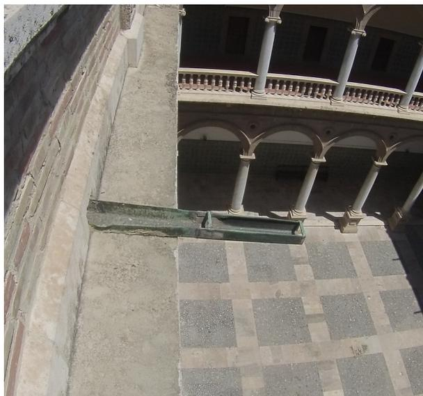
Figura 86. Canal a modo de gárgola de la cubierta plana del claustro
