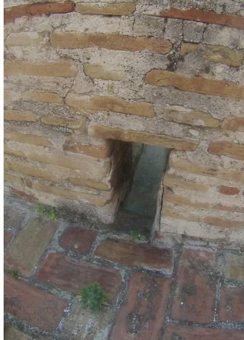
Figura 84. Mechinal situado en el antepecho de la cubierta inclinada de teja
