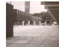
Pavimento de losas de hormigón
