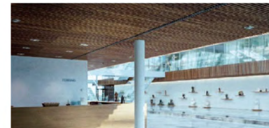
Falso techo de lamas de madera
