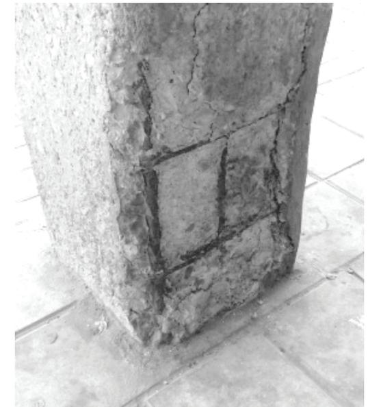
Pilar deteriorado dejando al descubierto las armaduras.
