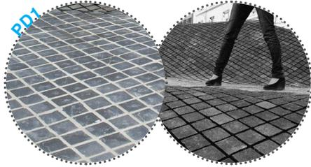
Pavimento de adoquines de hormigón de 10x10 cm. Sus pequeñas dimensiones permiten adaptarse a las formas curvas y a los juegos de desnivel que se han proyectado.
