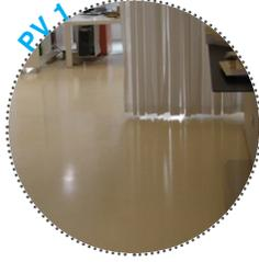
Se mantendrá el pavimento original, con sus imperfecciones por el desgaste y con las marcas dejadas por los muros eliminados, añadiendo una capa de resina autonivelante transparente.
