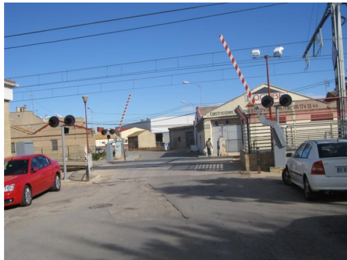
Imagen 7.67: Paso a nivel y plazas de aparcamiento próximas a la estación de RENFE.
