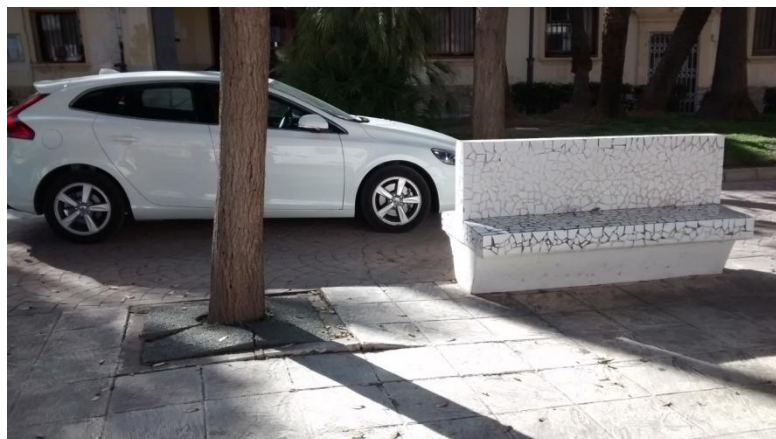
Imagen 7.39: alcorques cerrados con hormigón.
