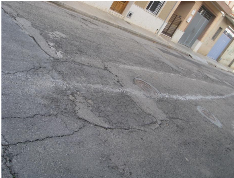
Imagen 7.17: Estado del asfalto en calle Capità Ibor.
