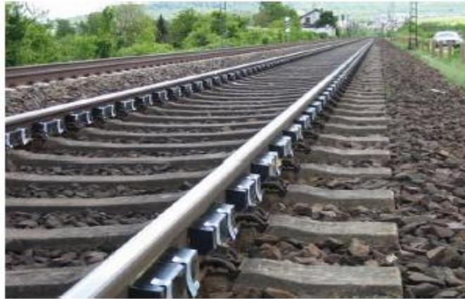
*Figura 2. 26 Material de amortiguamiento en el alma del carril.
