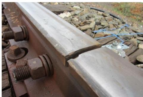
*Figura 2. 25 Junta con defecto. Fuente: Elaboración propia.*
