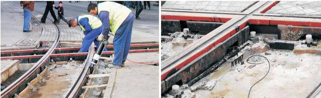
Figura 7.3 Adición de material elastomérico en la superficie de contacto carril-hormigón.
