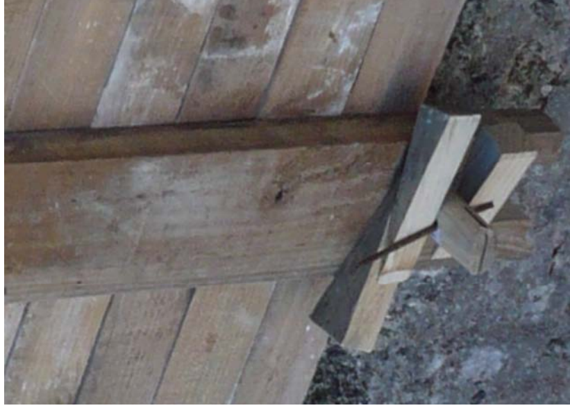
Encuentro agujá-costal (Intervención castillo de Alcalá de Gallinera)
