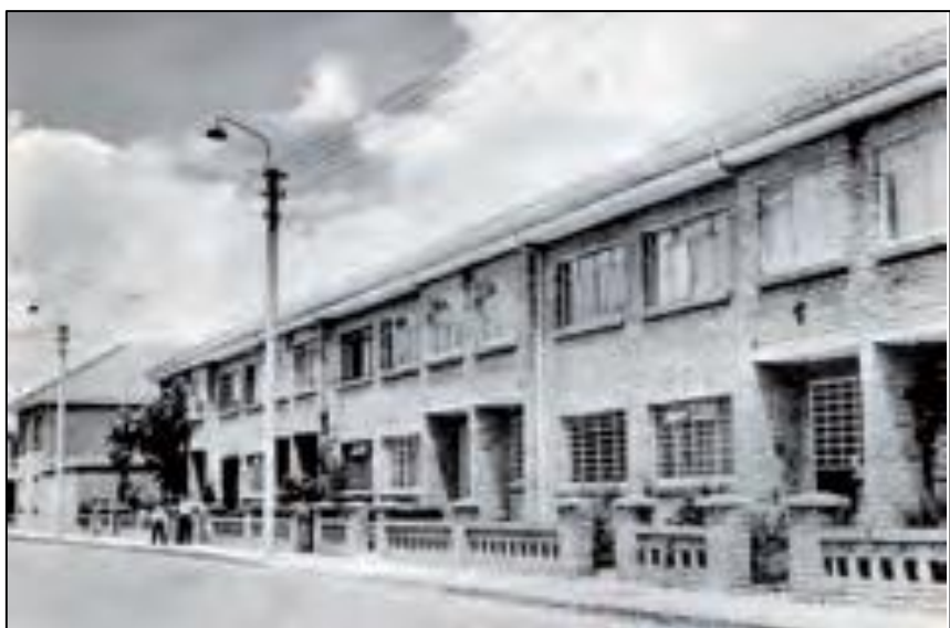
Imagen No. 6. Barrio Modelo Norte. Construido por la CVP. 1942.
