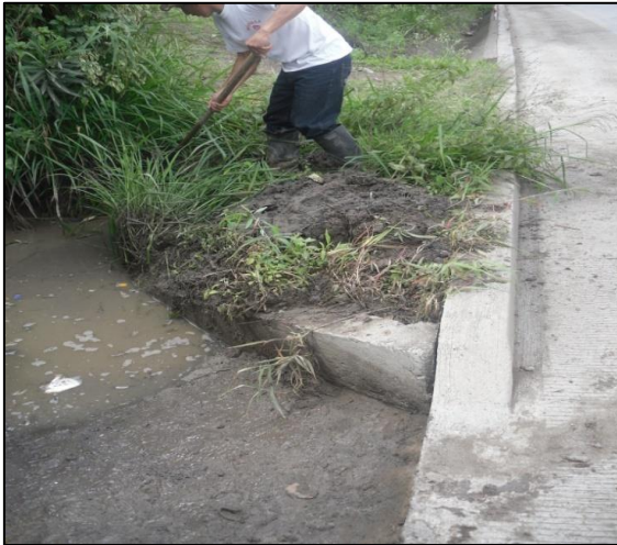
Ilustración 13 Entrada de la alcantarilla
