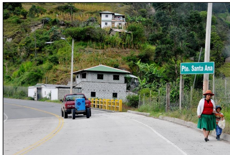
Ilustración 24 Puente sobre el Río Santa Ana
