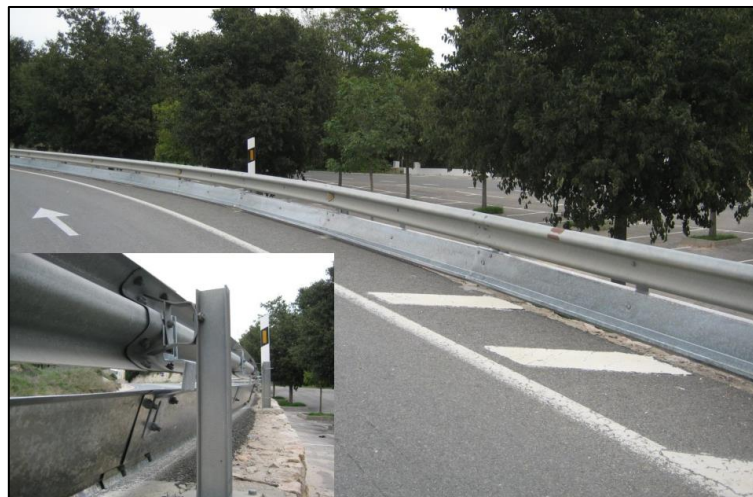
Ilustración 50 Refuerzo de barreras de seguridad
