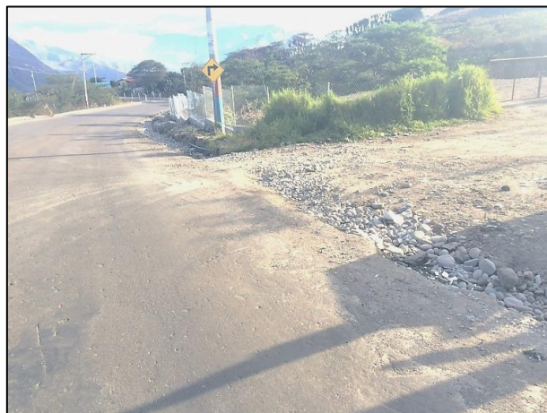
Ilustración 23 Accesos de tierra
