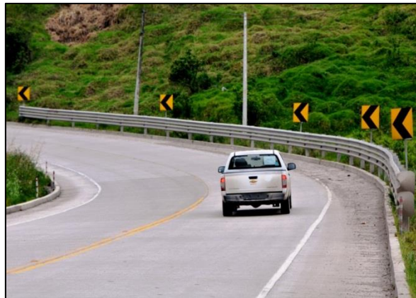
Ilustración 26 Barreras de seguridad
