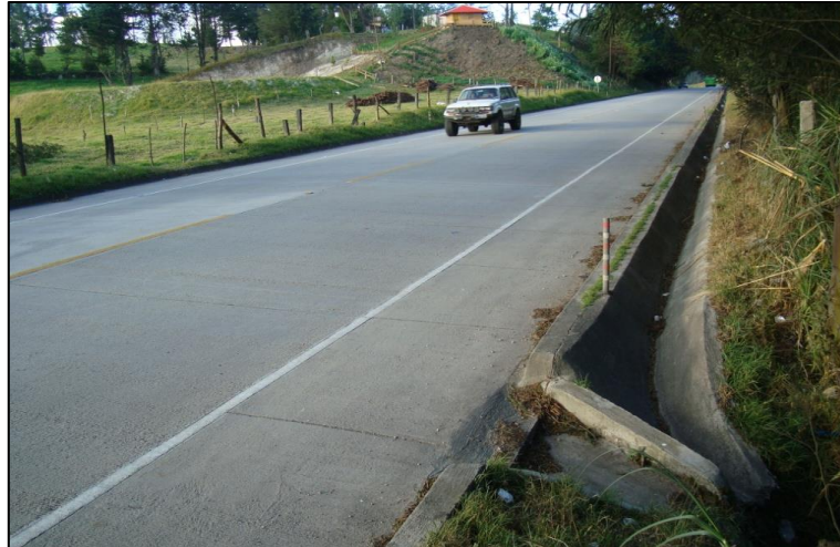
Ilustración 10 Sección de vía y cunetas
