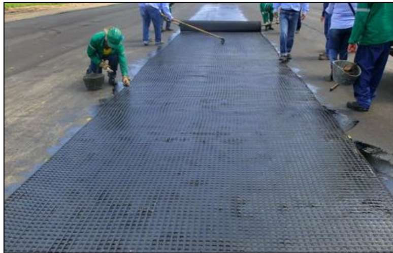
Ilustración 33 Ejemplo de colocación de geomalla
