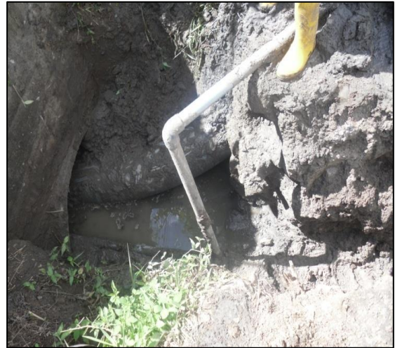
Ilustración 14 Salida de la alcantarilla
