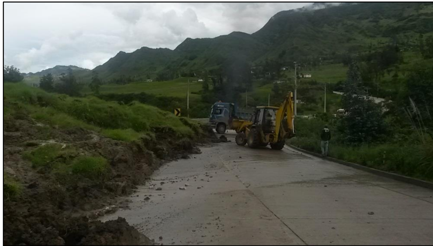
Ilustración 7 Deslizamiento de material PK.40+600
