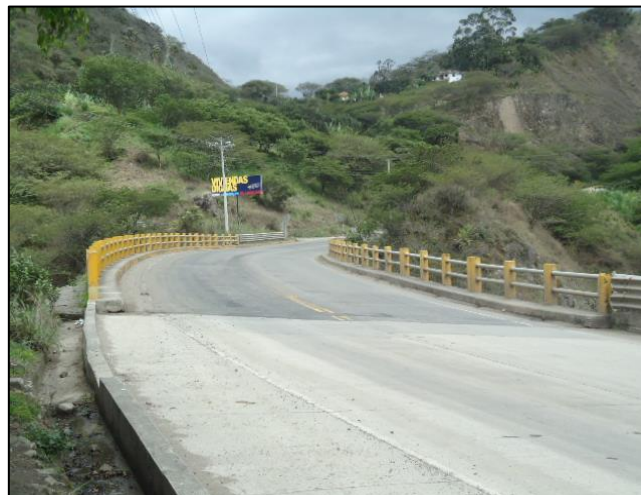
Ilustración 25 Puente sobre el Río Rircay
