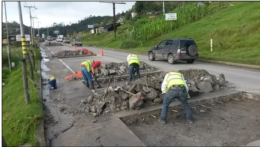
Ilustración 32 Proceso de reparación de losa
