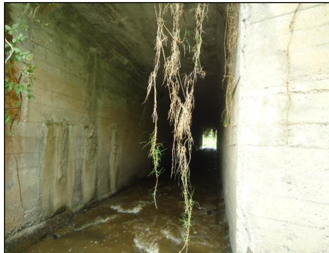
Ilustración 12 Alcantarilla tipo cajón
