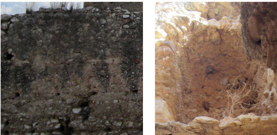
Fig. 9.12 - 9.13. Vistas del biodeterioro.
