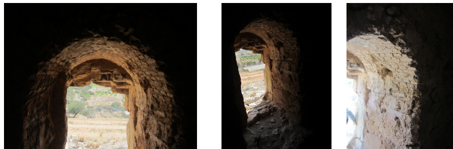
Fig. 7.32 - 7.34. Vistas interiores del acceso en la fachada Este.
