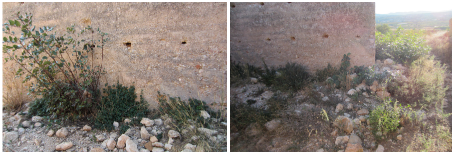
Fig. 9.24 - 9.25. Vegetación en la cimentación.
