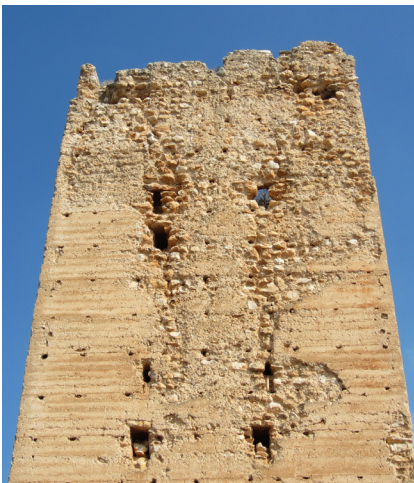
Fig. 9.45 - 9.46. Pérdida de costra en el alzado Sur y Este.
