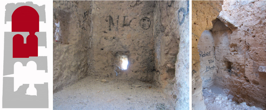
Fig. 6.39 - 6.40. Vista del intradós Sur. Detalle de la bóveda de la escalera del nivel 2 al nivel 3.
