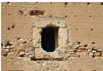
Fig. 9.47 - 9.49. Detalles de la pérdida de masa en el alzado Sur y Este.
