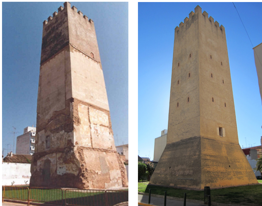
Fig. 4.63 - 4.64. Estado anterior y posterior a la intervención de la torre Racef.
