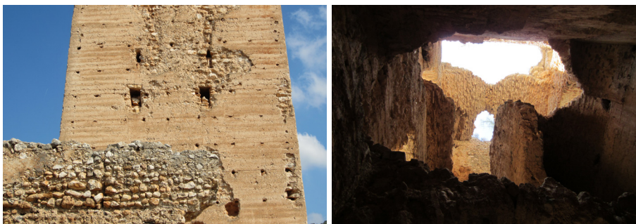
Fig. 9.5 - 9.6. Vista del alzado Sur. Vista cenital del interior de la torre.
