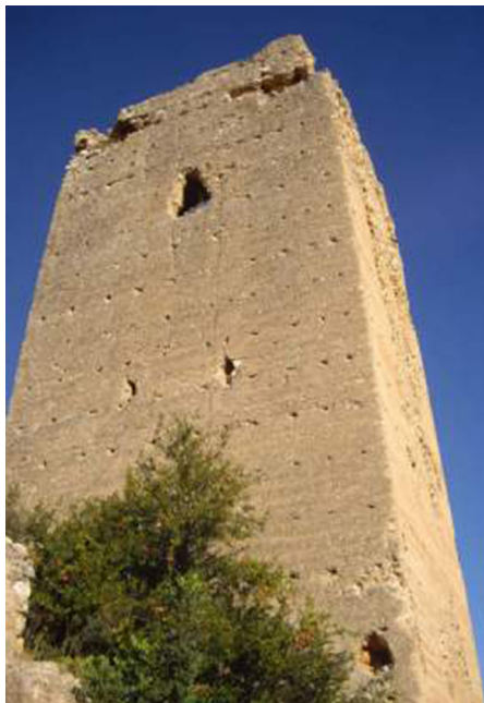
Fig. 9.38 - 9.39. Imagen del árbol que provocó la erosión y vista del alzado Oeste sin el árbol.
