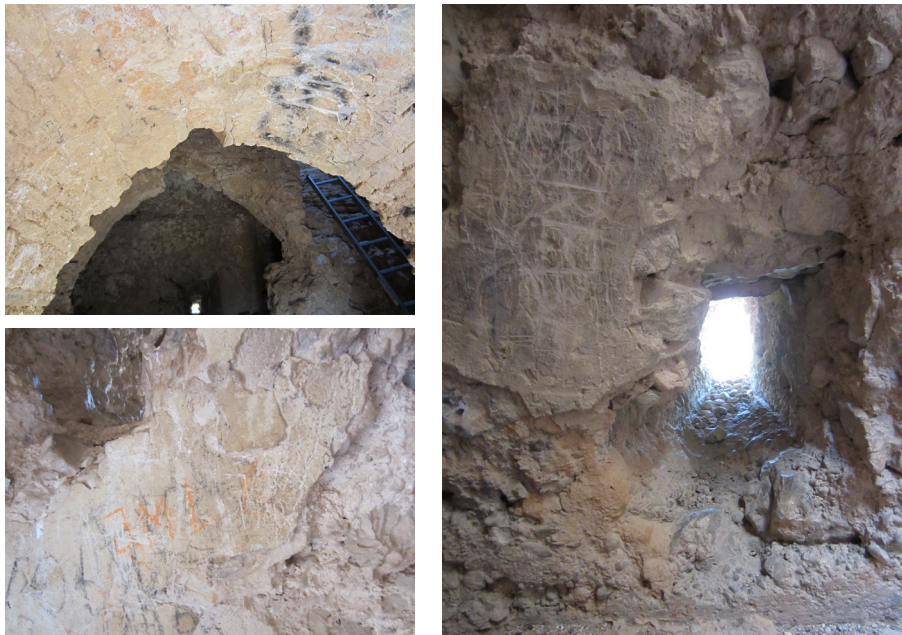
Fig. 9.34 - 9.36. Rascaduras del hueco de acceso y del interior del muro en el nivel 2.
