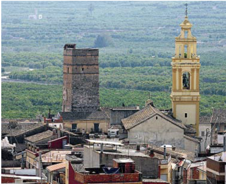
Fig. 4.57. Vista de la torre y del campanario de la iglesia de Antella.
