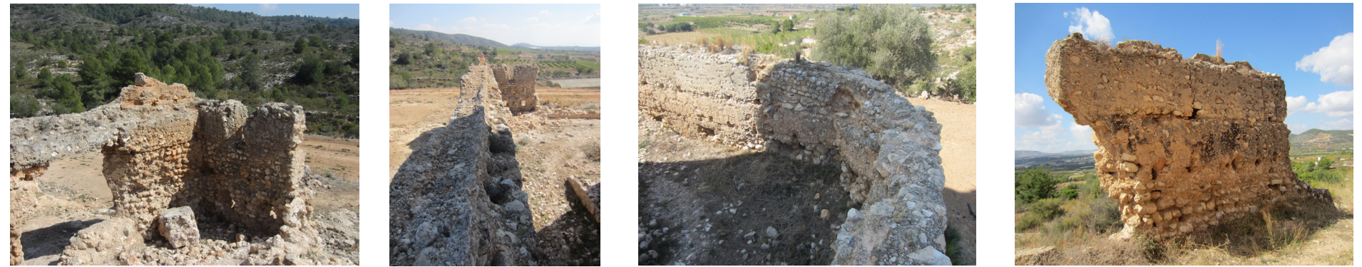
Fig. 6.8 - 6.11. Vistas del albacar desde el interior del recinto. De izquierda a derecha: vista del muro Noreste. Vista del muro Oeste. Restos de muro del albacar Sur.
