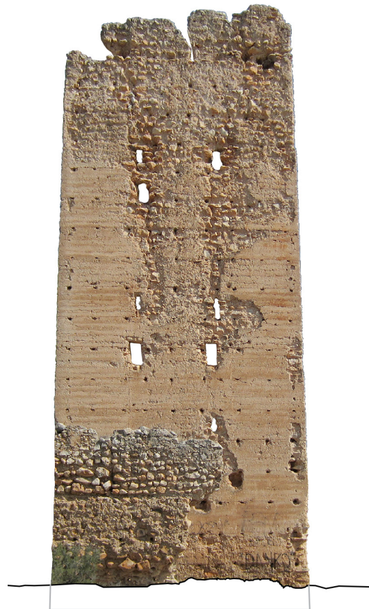
Fig. 6.31. Levantamiento ortofotogramétrico del alzado Sur. (Elaboración propia) e: 1/150
