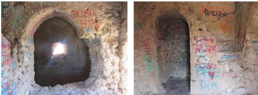
Fig. 4.16 - 4.17. Vista del muro diafragmático que separa la planta en el nivel 1. Arranque de las escaleras del nivel 1 al nivel 2.
