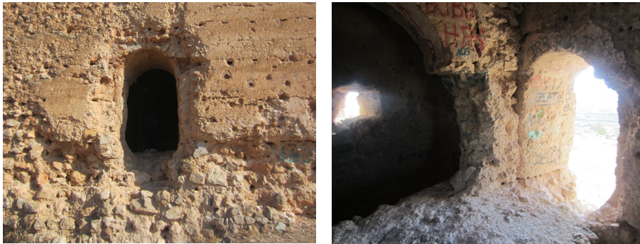
Fig. 4.14 - 4.15. Vista del acceso a la torre desde el exterior y del interior.
