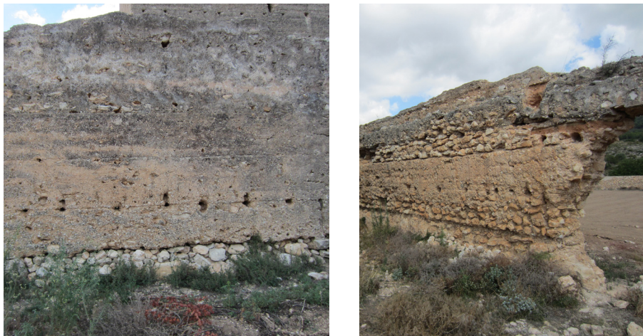
Fig. 9.3 - 9.4. Vistas del alzado Norte del albacar en su cara exterior e interior.
