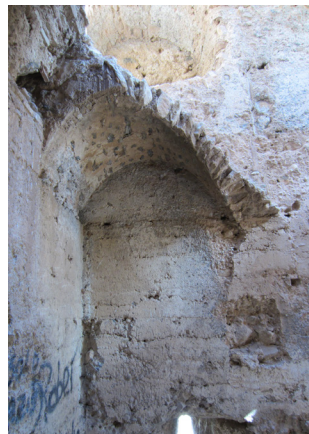
Fig. 7.27 - 7.28. Restos de la escalera del nivel 2 al nivel 3. Bóveda del desembarco de la escalera en el nivel 3.
