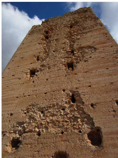
Fig. 9.47 - 9.49. Detalles de la pérdida de masa en el alzado Sur y Este.
