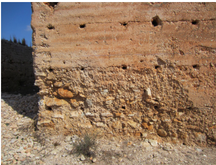
Fig. 7.2 - 7.3. Cimentación en el alzado Sur.
