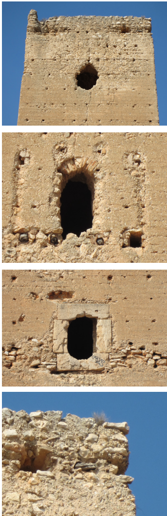
Fig. 6.12 - 6.15. Coronación fachada Este. Matacán nivel 2. Acceso torre en el nivel 1. Restos de redondos de los cadalsos de la crestería.
