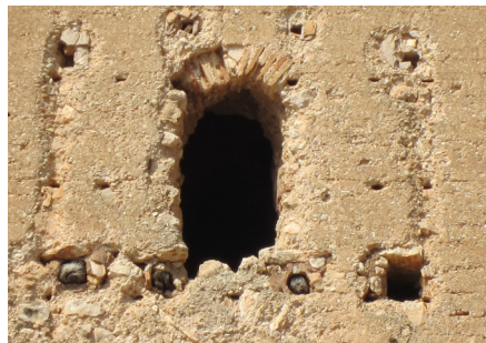
Fig. 3.20 - 3.21. Matacán situado encima del acceso de la torre de Montroi y de la torre Alédua.
