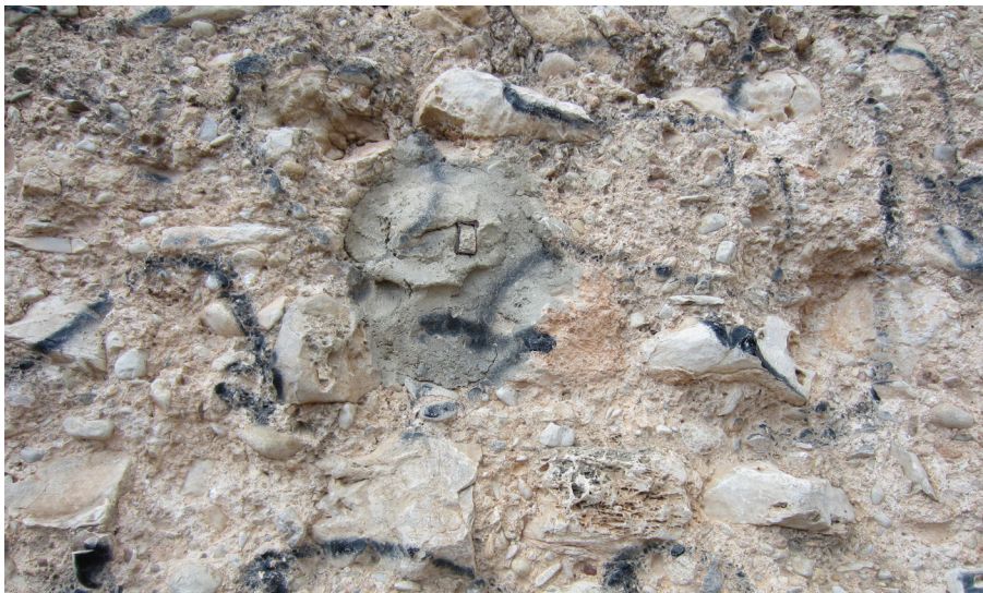
Fig. 9.37. Vista del perfil metálico incrustado en la fachada Este.
