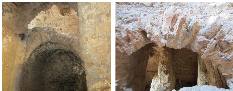
Fig. 7.23 - 7.24. Detalle de la bóveda de la escalera del nivel 1 al nivel 2.
