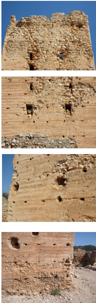
Fig. 6.27 - 6.30. Coronación fachada Sur. Saeteras nivel 2. Detalle de los huecos. Vista de la base de la Torre.
