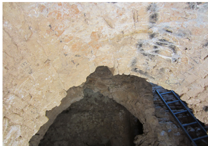
Fig. 9.16 - 9.19. Fisuras en el arco del muro diafragmático del nivel 1 y de los elementos pétreos del acceso.
