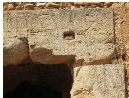
Fig. 9.16 - 9.19. Fisuras en el arco del muro diafragmático del nivel 1 y de los elementos pétreos del acceso.
