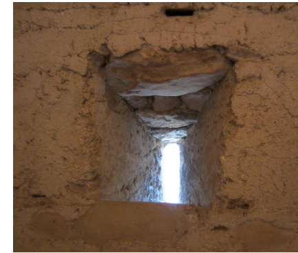
Fig. 3.22 - 3.23. Vista exterior de las saeteras de la torre de la Plaza de Benifaió. Detalle del interior.
