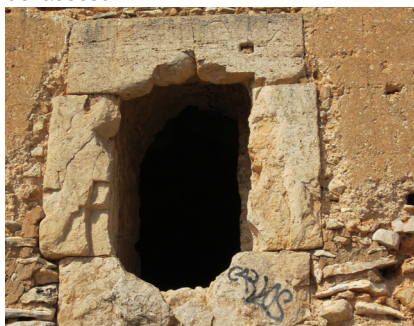
Fig. 9.16 - 9.19. Fisuras en el arco del muro diafragmático del nivel 1 y de los elementos pétreos del acceso.
