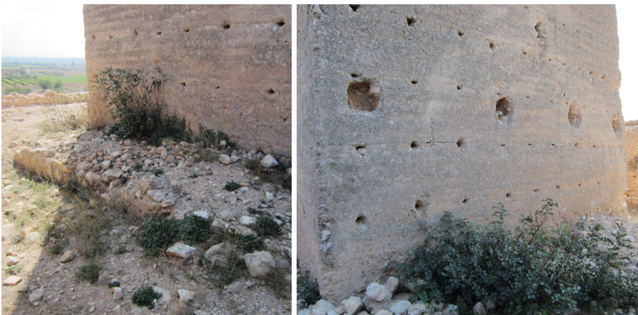
Fig. 9.43 - 9.44. Vista de la cimentación en el alzado Norte y Oeste.
