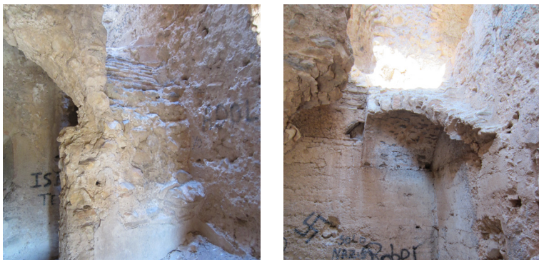
Fig. 9.7 - 9.8. Restos de la escalera del nivel 1 y vista de la bóveda de arranque de la escalera del nivel 3.
