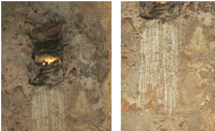
Fig. 9.41 - 9.42. Saetera intradós Sur del nivel 1. Detalle del chorretón de la saetera.
