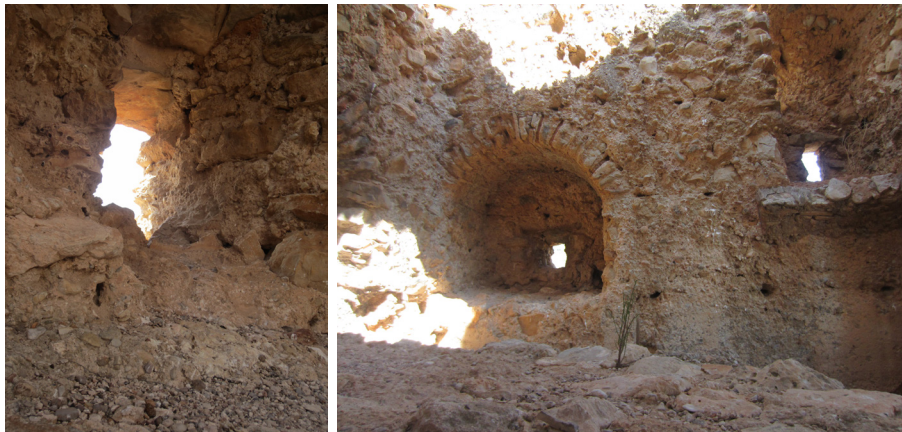
Fig. 6.41 - 6.42. Saetera del intradós Sur del nivel 3. Detalle de los nichos practicados en el intradós Norte.
