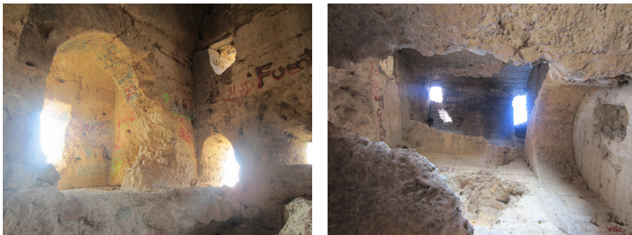
Fig. 4.18 - 4.19. Vista del nivel 2 y vista cenital de la torre desde el nivel 1.
