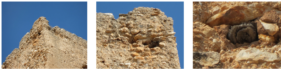
Fig. 7.54 - 7.56. Detalle de los maderos de los cadalsos. Esquina Sureste.
