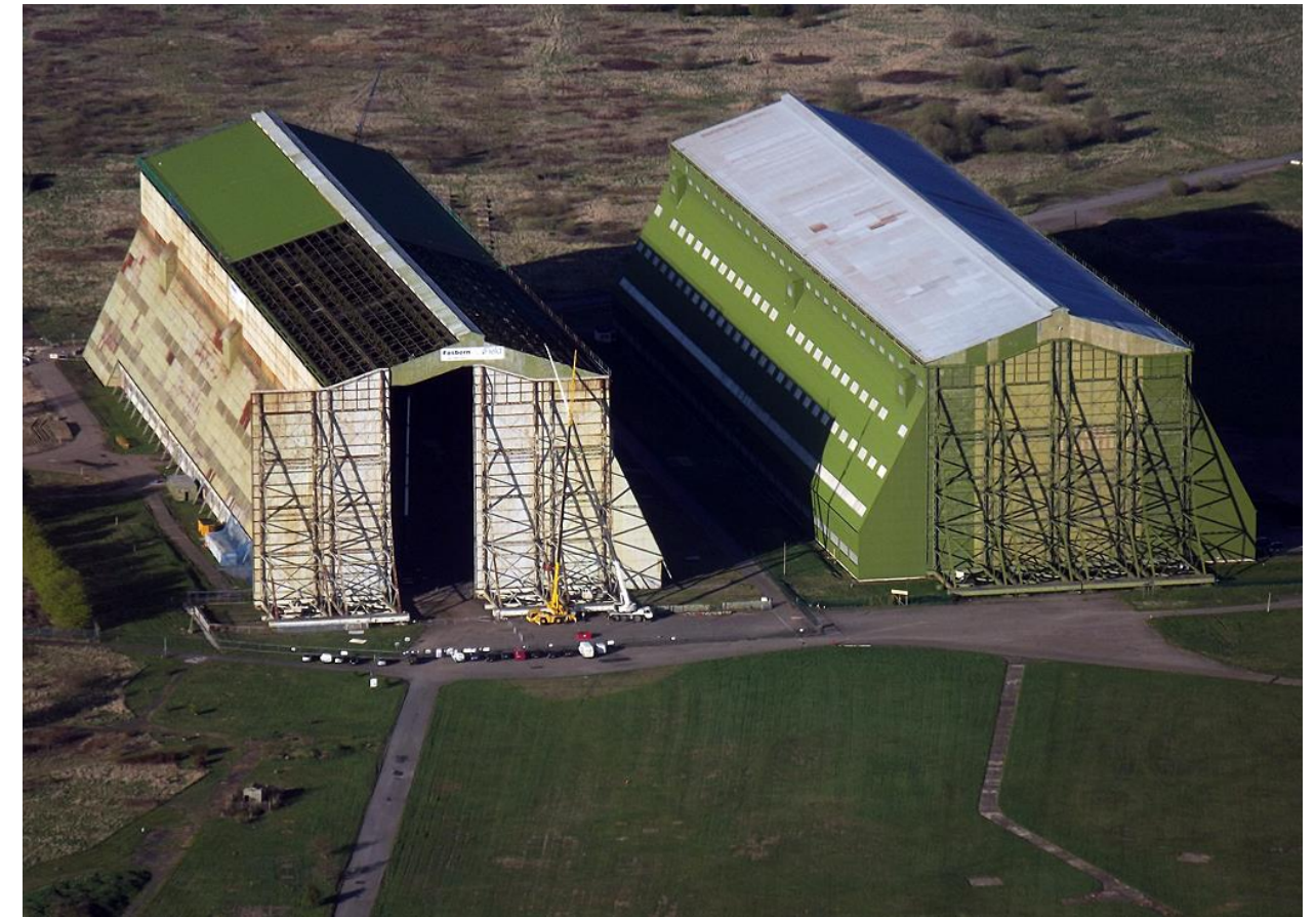
Figura 1.2. Hangares de la Fuerza Aérea Real Británica en la localidad de Cardington Bedfordshire, Inglaterra
