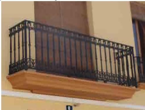
[72] Balcón de vuelo de losa con barandilla de fundición, primer cuarto del siglo XX
