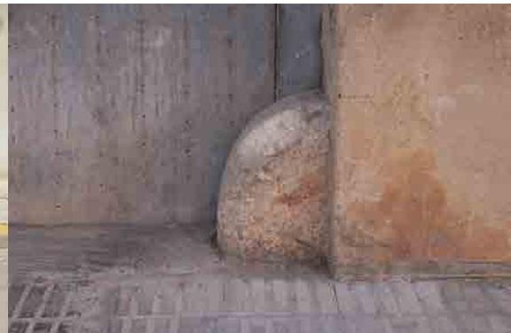
[52] Guardaejes con forma de zapata ondulante
