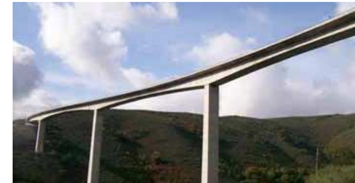
Figura 7- Puente pretensado de canto variable
