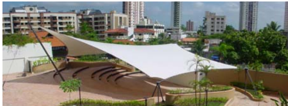
Figure 6: The membrane roof of the “ Memorial dos Povos de Belém do Pará ”
