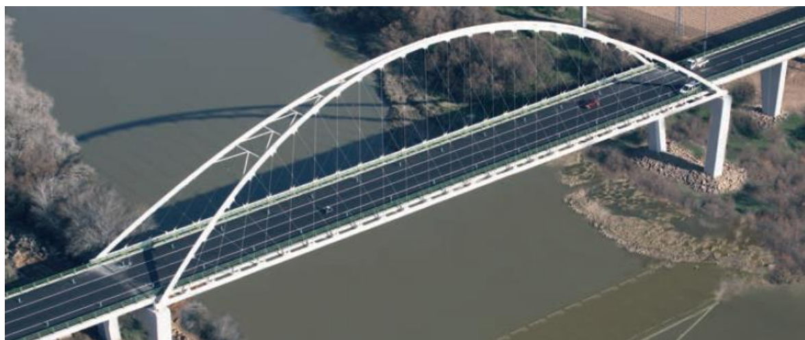
Figura 20 Vista del puente arco sobre el río Deba [Ortega 2010]
