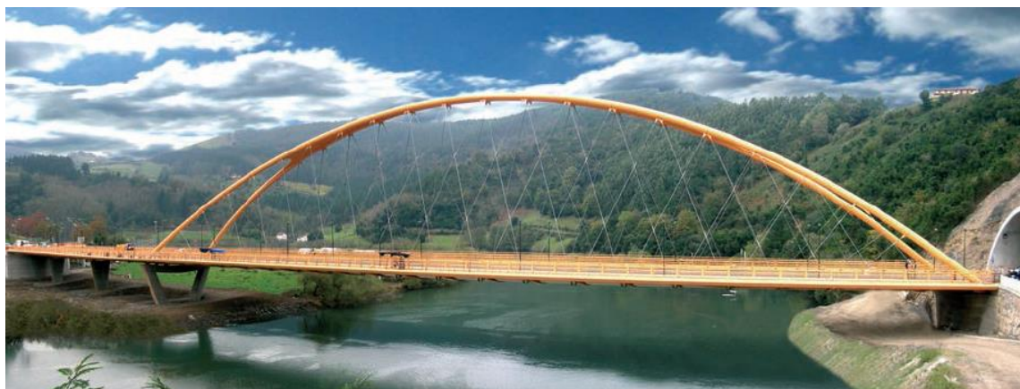
Figura 19 Vista del puente arco sobre el río Deba [Ortega 2010]
