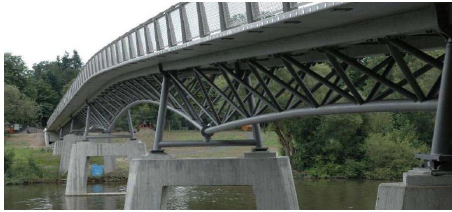
Figura 2 Pasarela sobre el río Fulda en Kassel [Fehling 2009]
