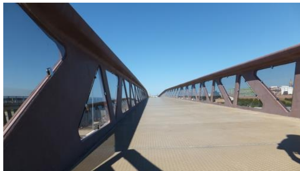
Figura 12 Vista del vano central de la pasarela sobre la V-21 [RDC 2016]
