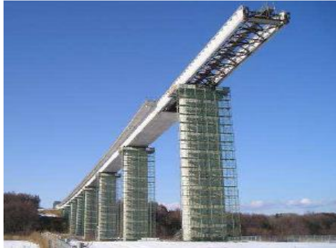
Figura 7 Nariz de lanzamiento durante proceso constructivo [Tanaka et al. 2009]
