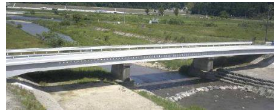
Figura 5 Pasarela Hikita [Tanaka et al. 2009]
