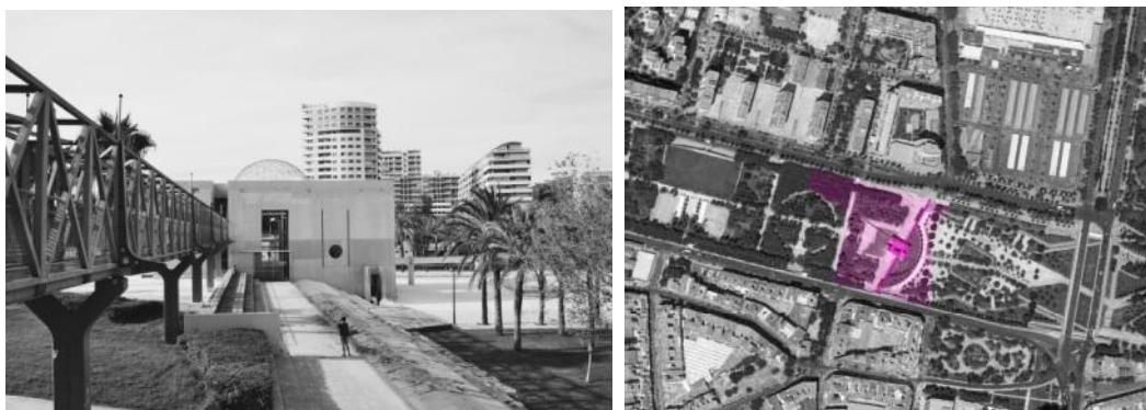
Fig. 5 Fotografías de La Casa del Agua: vista general y vista aérea
