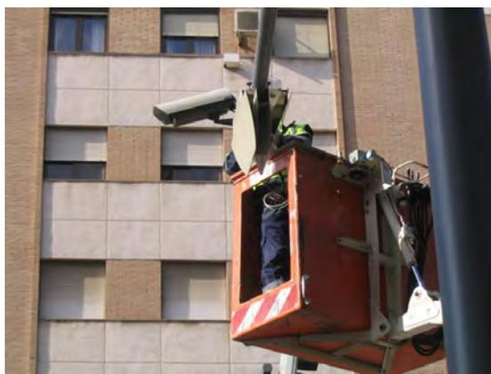
(b) Instalación de la cámara
