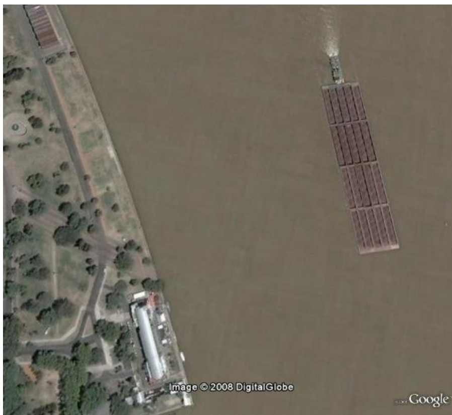
Figura V-2.- Barcazas en la zona de baja profundidad de la Hidrovía.
