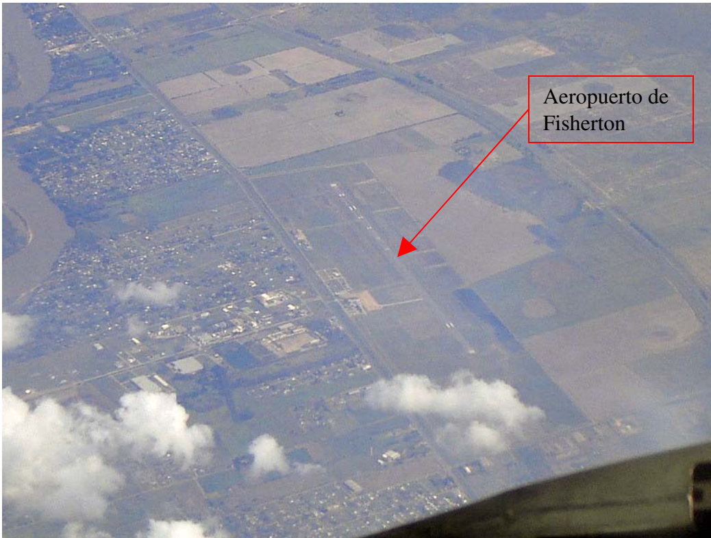
Figura IV-21. Vista aérea del Aeropuerto de Fisherton. Ubicado a 15Km de la ciudad de Rosario.
