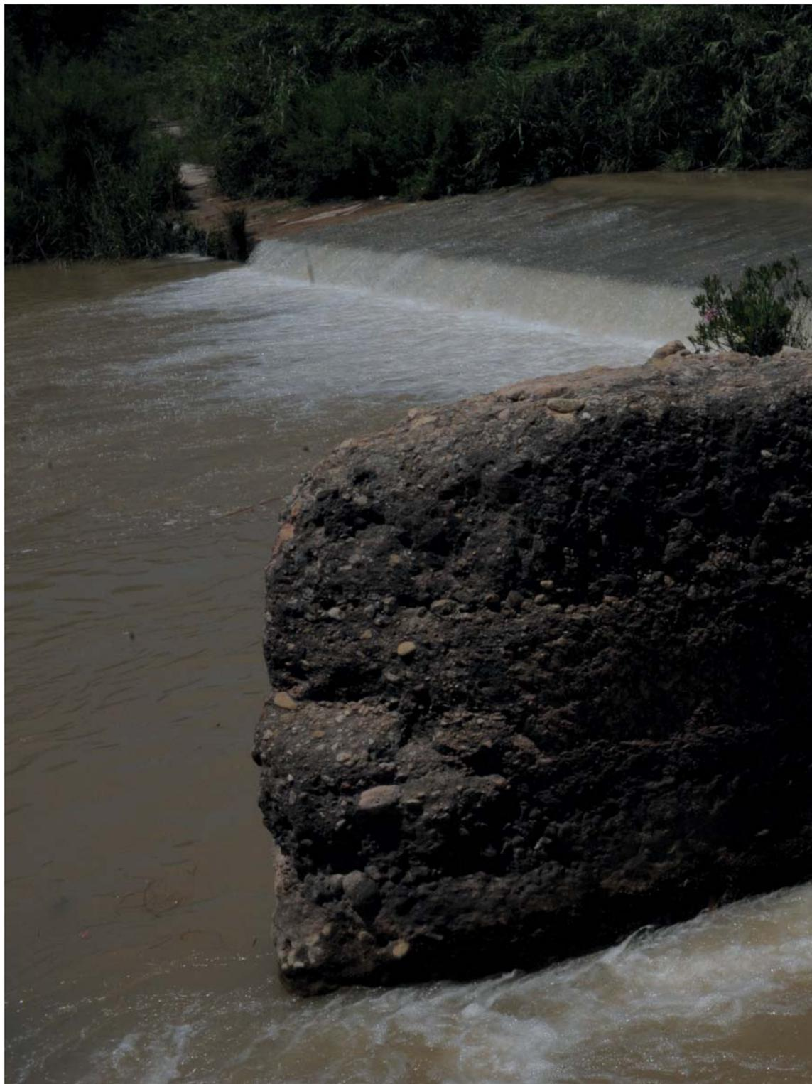
*Fig. 083. Imagen del açud de La Pobla de Vallbona y Benaguacil sobre el río Túria. También se observa la compuerta la Real. En el paramento vertical se observan sillares de la compuerta original.*
