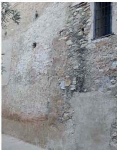
Fig. 171. Posibles restos del paramento vertical de la torre gótica en la fachada medianera situada frente al fossar medieval.
