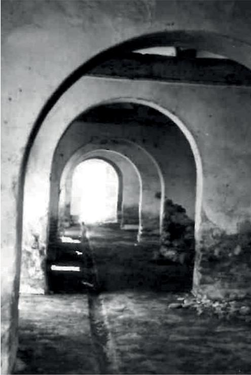
*Fig. 146. Muros de carga del interior de la Casa Blanca.*
