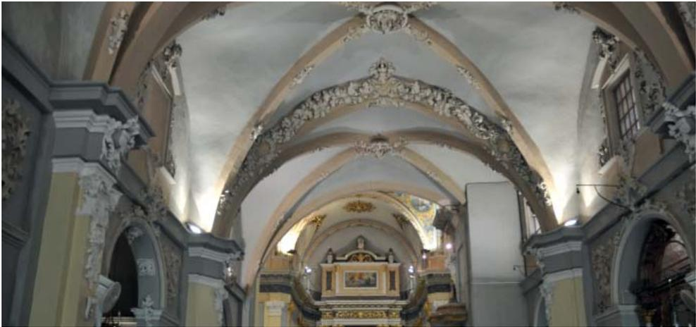
Fig. 170. Bóvedas barrocas tapando los arcos apuntados medievales y las bóvedas de crucería conforme al gusto barroco del a reforma efectuada.
