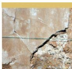
1.fisuración 2.erosión 3.pérdida de material 4.alteración cromática
