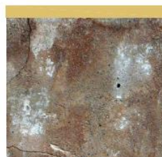
1.fisuración 2.erosión 3.pérdida de material 4.alteración cromática
