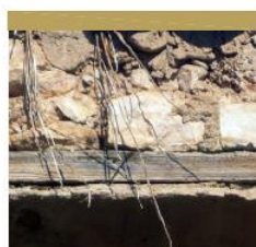
1.oxidación del metal 2.insectos xilófagos 3.falta de material 4.graffiti
