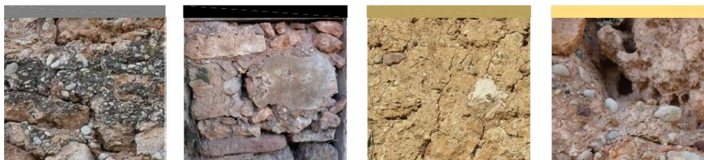
1.micro-vegetación 2.pérdida de material 3.fisuración 4.erosión
