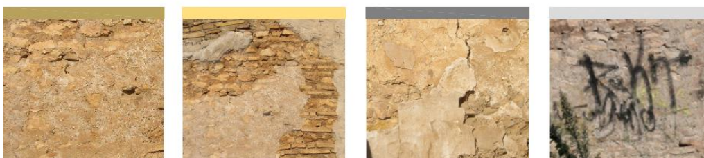
1.erosión 2.pérdida de material 3.fisuración 4.graffiti
