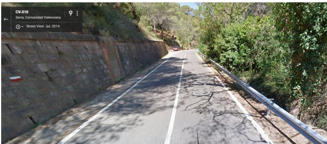
Imagen 31: ejemplo muro de contención de tierras 2 (Contenidos audiovisuales/capturas de Google/Serra-El Tochar/P.K. 22+000 (96).jpg)
