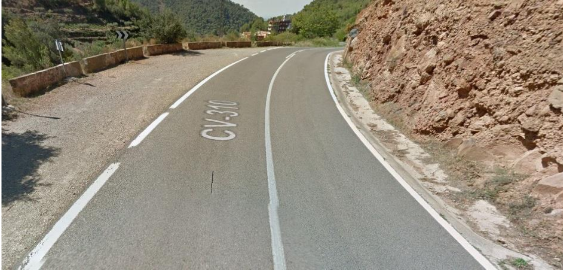
Imagen 4: cunetas de drenaje 1 (Contenidos audiovisuales/ capturas de Google/El Tochar-Serra/P.K. 22+000 (422).jpg)
