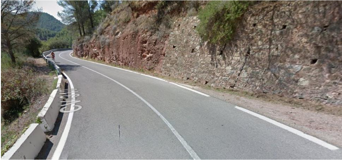
Imagen 37: ejemplo muro de contención de tierras 8 (Contenidos audiovisuales/capturas de Google/ El Tochar-Serra/P.K. 22+000 (378).jpg)
