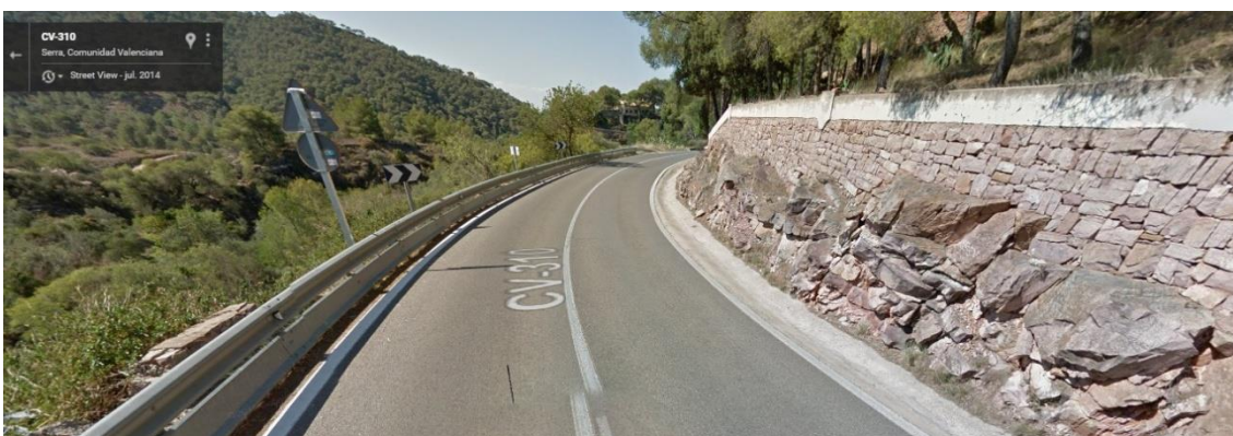
Imagen 34: ejemplo muro de contención de tierras 5 (Contenidos audiovisuales/capturas de Google/ El Tochar-Serra/P.K. 21+000 (447).jpg)
