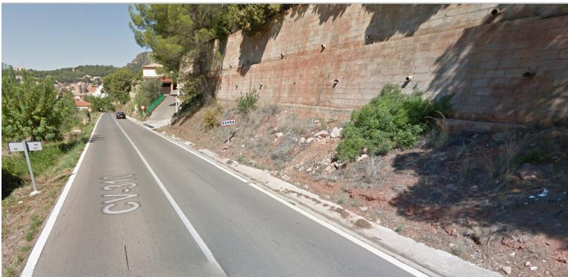
Imagen 36: ejemplo muro de contención de tierras 7 (Contenidos audiovisuales/capturas de Google/ El Tochar-Serra/P.K. 21+000 (471).jpg)
