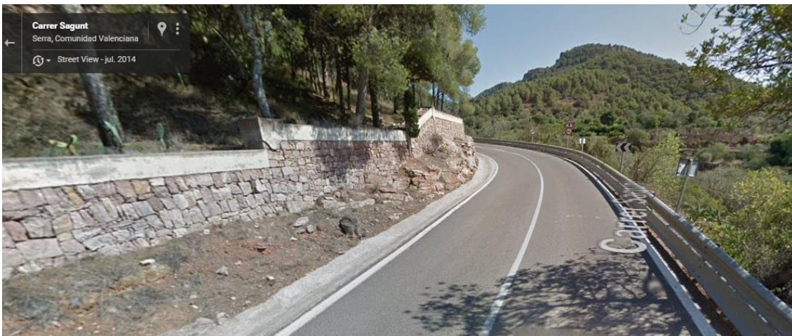
Imagen 33: ejemplo muro de contención de tierras 4 (Contenidos audiovisuales/capturas de Google/Serra-El Tochar/P.K. 21+000 (36).jpg)
