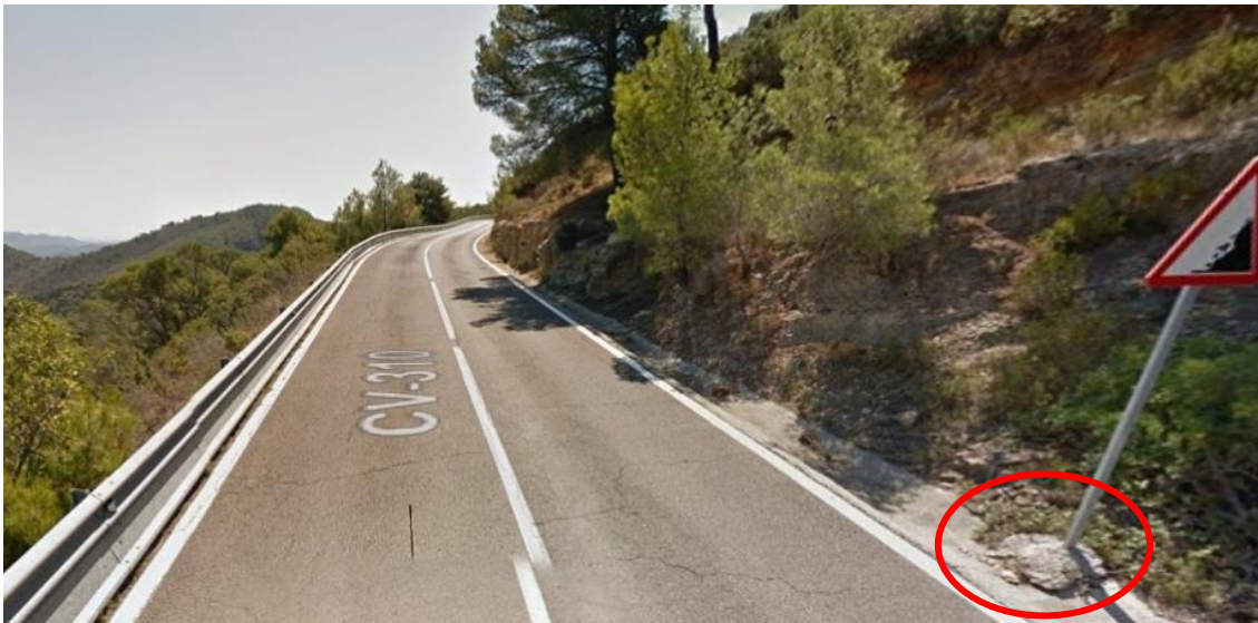
Imagen 9: cunetas de drenaje 6
