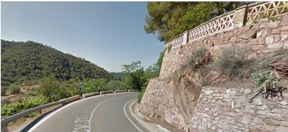
Imagen 35: ejemplo muro de contención de tierras 6 (Contenidos audiovisuales/capturas de Google/ El Tochar-Serra/P.K. 21+000 (466).jpg)
