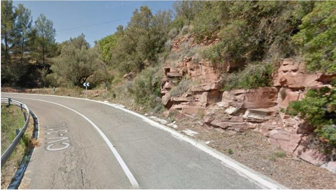
Imagen 6: cunetas de drenaje 3 (Contenidos audiovisuales/capturas de Google/El Tochar-Serra/P.K. 22+000 (426).jpg)
