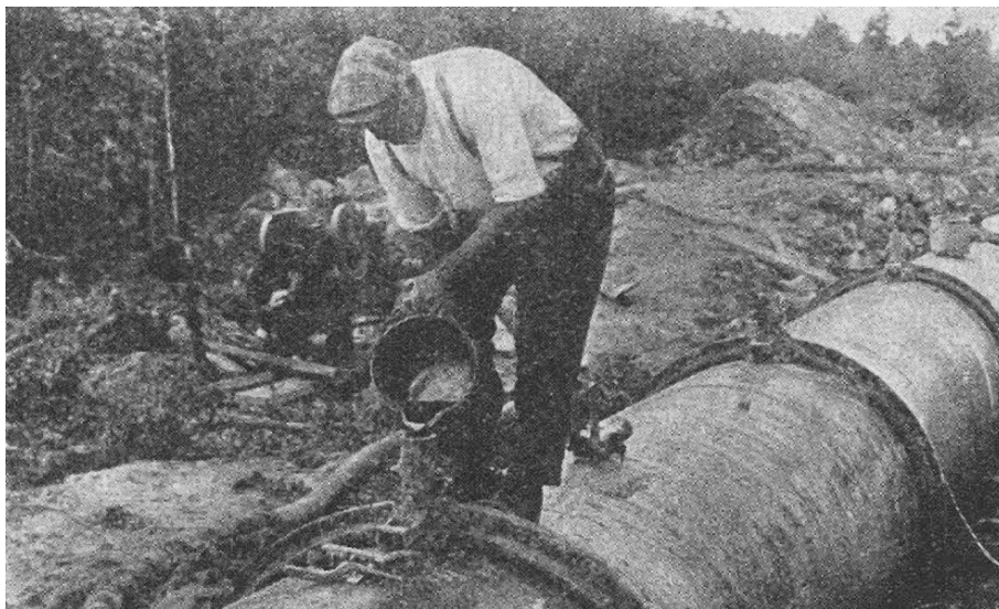
FIGURA 18. TUBERÍA DE FUNDICIÓN GRIS REVESTIDA CON PLOMO.
