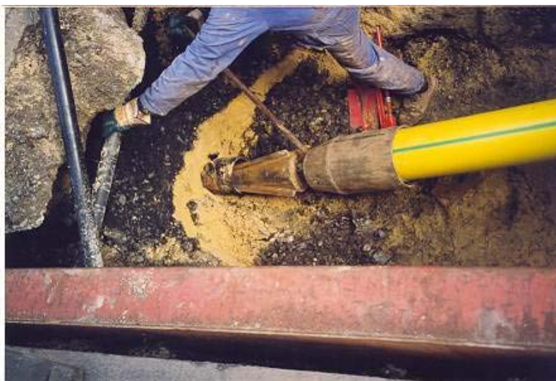
FIGURA A.34. UNIÓN DEL CABEZAL DE TIRO Y LA PIEZA UTILIZADA PARA EL ENSANCHAMIENTO.
