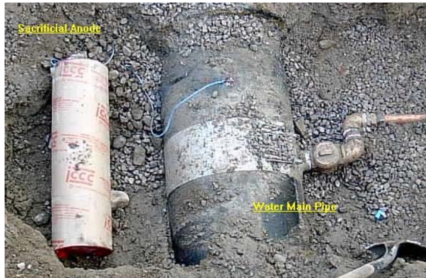
FIGURA 21. INSTALACIÓN DE UN ÁNODO DE SACRIFICIO EN UNA TUBERÍA METÁLICA.
