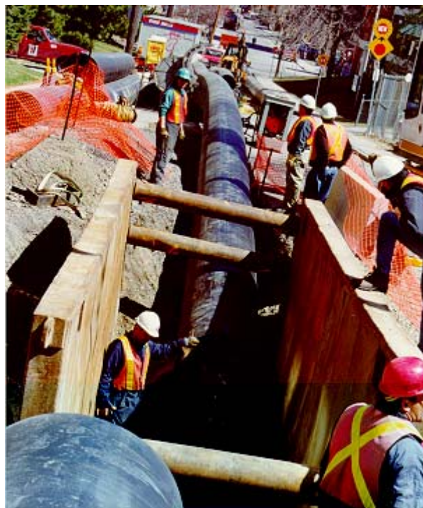
FIGURA A.21. CATA DE ENTRADA EN UNA RENOVACIÓN EN TUBERÍA DE 910 MM DE FUNDICIÓN GRIS MEDIANTE ENTUBADO POR DESLIZAMIENTO CON TUBERÍA DE POLIETILENO DE 840 MM, OTTAWA, CANADÁ.
