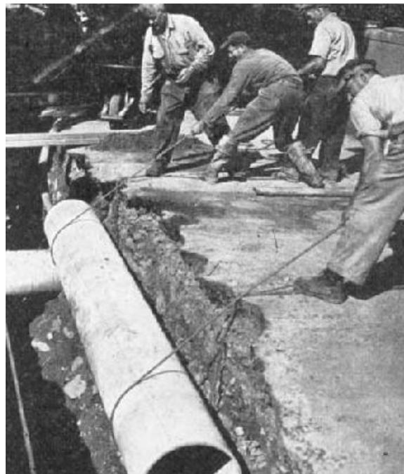
FIGURA 17. INSTALACIÓN DE TUBERÍA DE FIBROCEMENTO, AÑO 1953.
