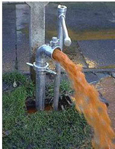
FIGURA A.14. SALIDA DE UNA DESCARGA DE AGUA.
