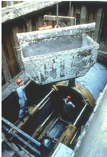
FIGURA A.50. DISPOSITIVOS HIDRÁULICOS DE PERFORACIÓN.
