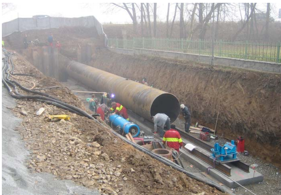
FIGURA A.47. HINCA DE TUBERÍA DE ACERO DE 1800 MM QUE CRUZA UNA AUTOPISTA EN PRAGA, DICIEMBRE DE 2006.
