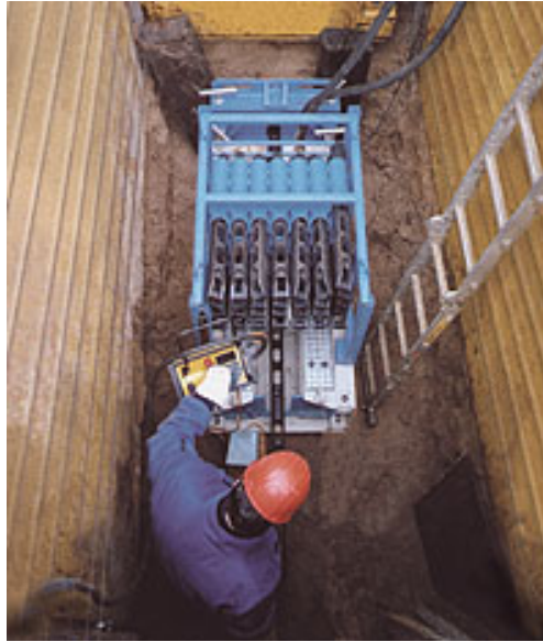
FIGURA A.31. CATA DESDE LA QUE SE REALIZAN DISTINTAS TÉCNICAS.
