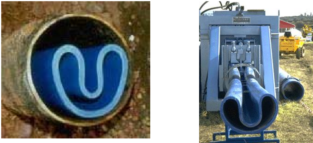
FIGURA A.25. VISTA DE LA DEFORMACIÓN REALIZADA SOBRE LA TUBERÍA DE POLIETILENO Y UN EJEMPLO DE DEFORMACIÓN IN-SITU.
