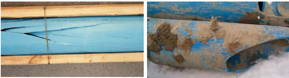
FIGURA 30. ROTURA FRÁGIL DE TUBERÍA DE PVC.
