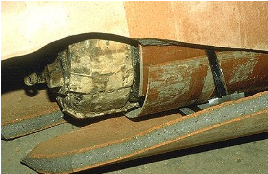
FIGURA A.37. CABEZAL DE TIRO QUE PRODUCE UNA ROTURA EN LA TUBERÍA MEDIANTE PERCUSIÓN NEUMÁTICA.
