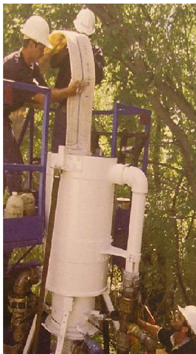
FIGURA A.26. INSTALACIÓN DE MANGA INVERTIDA PARA REHABILITACIÓN
