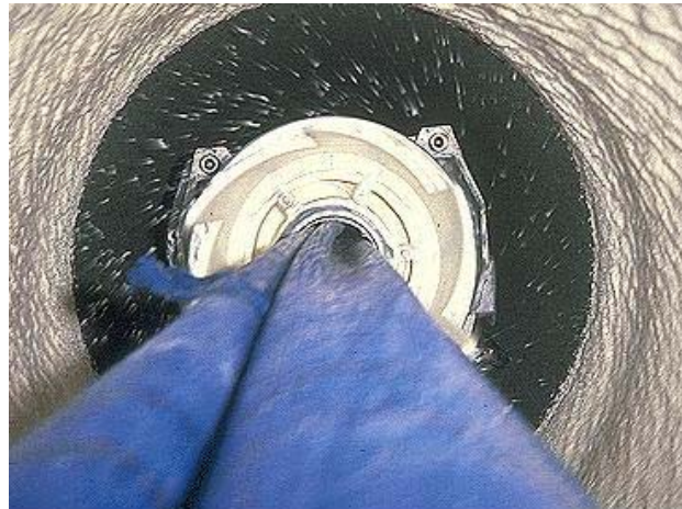
FIGURA A.11. MECANISMO DE INYECCIÓN DE RESINAS QUE SIRVEN COMO REVESTIMIENTO NO ESTRUCTURAL.
