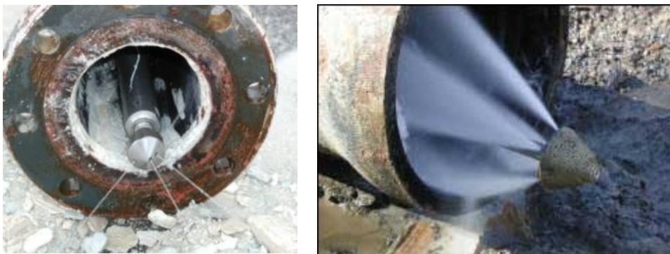
FIGURA A.16. INYECCIÓN DE AGUA A ALTA PRESIÓN.
