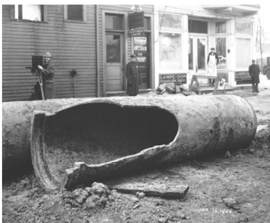
FIGURA 36. TIPOS DE ROTURA EN TUBERÍA DE FUNDICIÓN GRIS.
