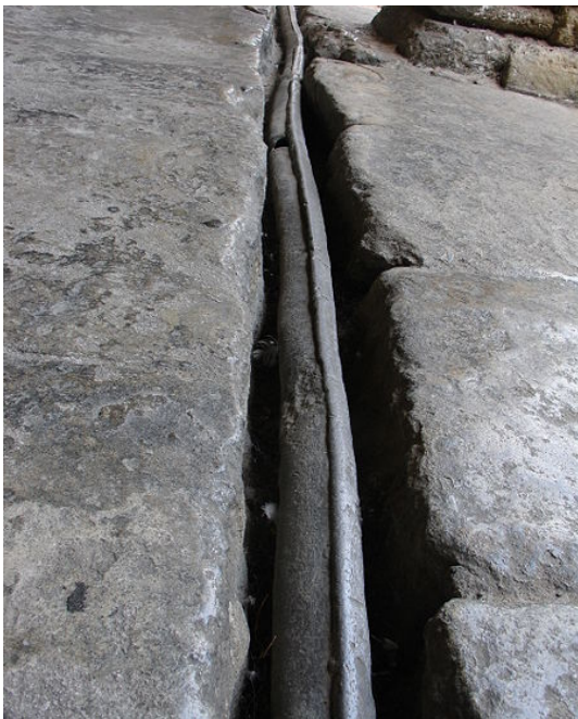
FIGURA 12. TUBERÍA DE PLOMO EN BATH.
