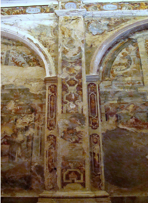
Lado del Evangelio. Primer tramo de la nave, pilastra representando a San Juan Apóstol.
