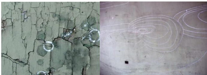
Figs. 337-338 Proceso de la intervención (detalle)
