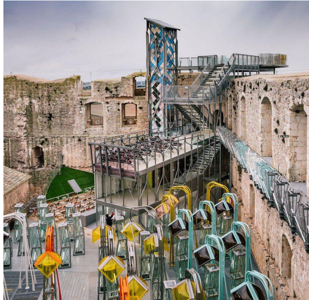
Imagen 8: Patio de armas después de la última intervención
