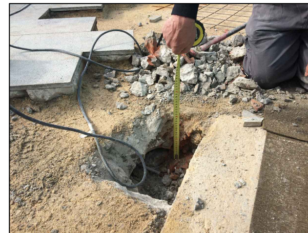
Espesor de solera existente (25 cm)
