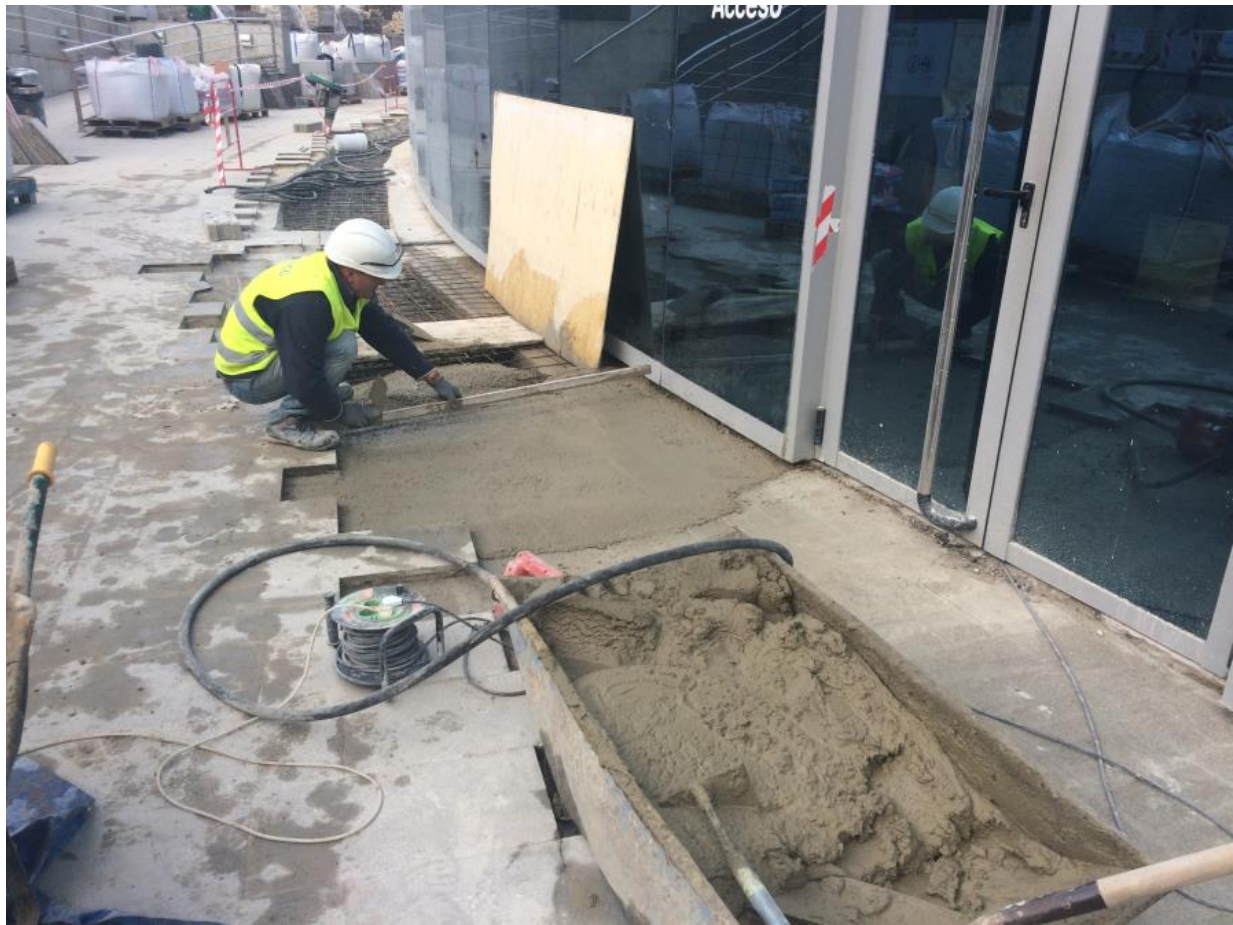
Hormigonado de la zona de acceso al auditorio Mar Rojo.
