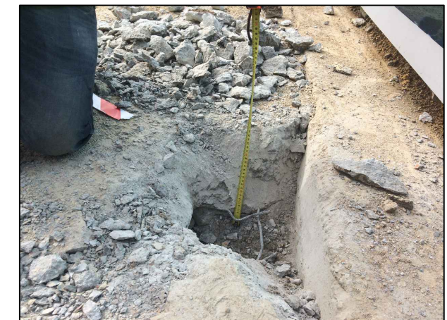
Foto de la losa con el mallazo en la parte inferior colocado (cata 2).
