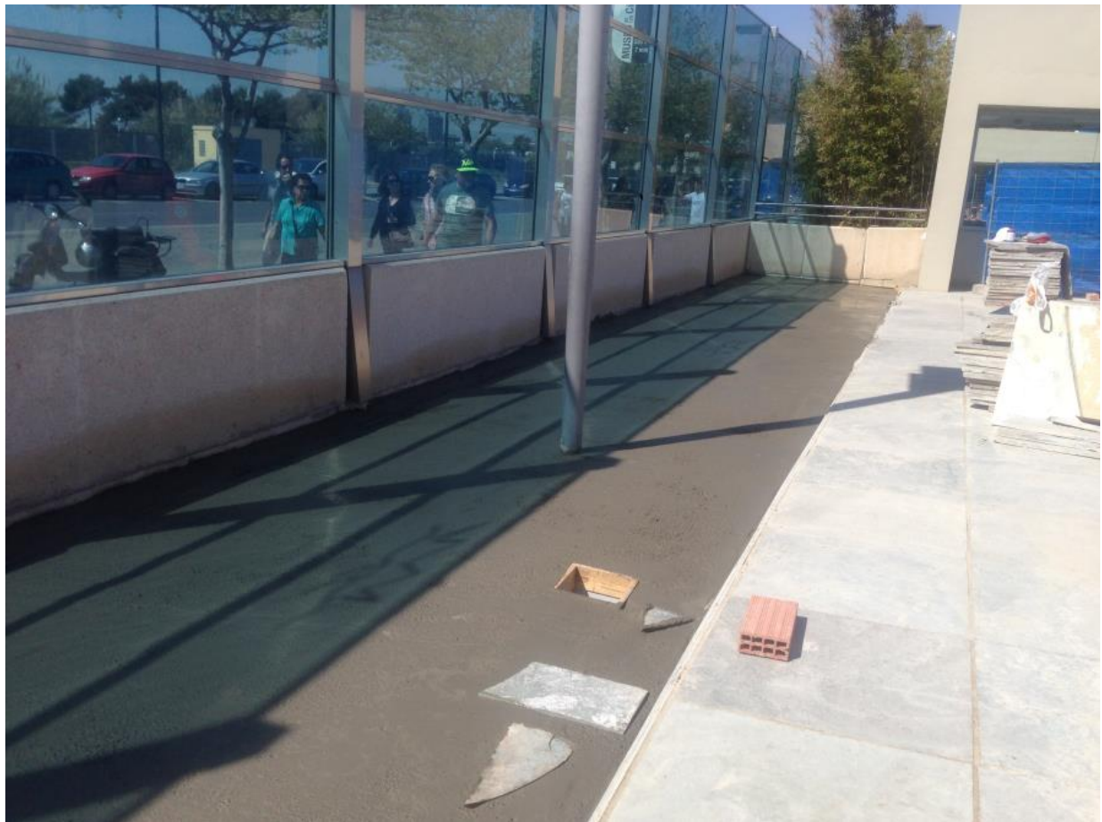
Hormigonado en uno de los tramos de la Plaza de Acceso.
