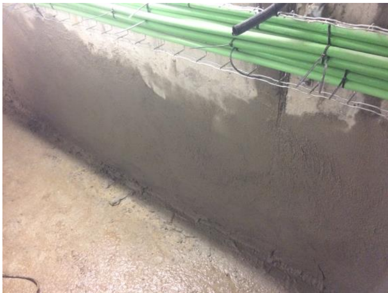
Figura 10. Acabado final de la reparación de muros de estructura de hormigón armado. 2017. Fuente: Fotografía tomada en obra. Martín Arcos, J. J.
