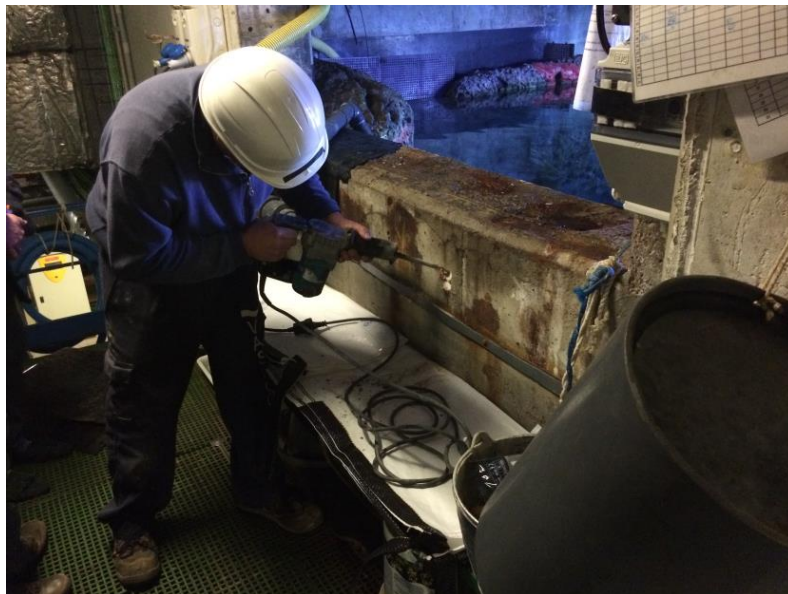
Figura 8. Picado de muro de hormigón armado en borde de acuario. 2017. Fuente: Fotografía tomada en obra. Martín Arcos, J. J.
