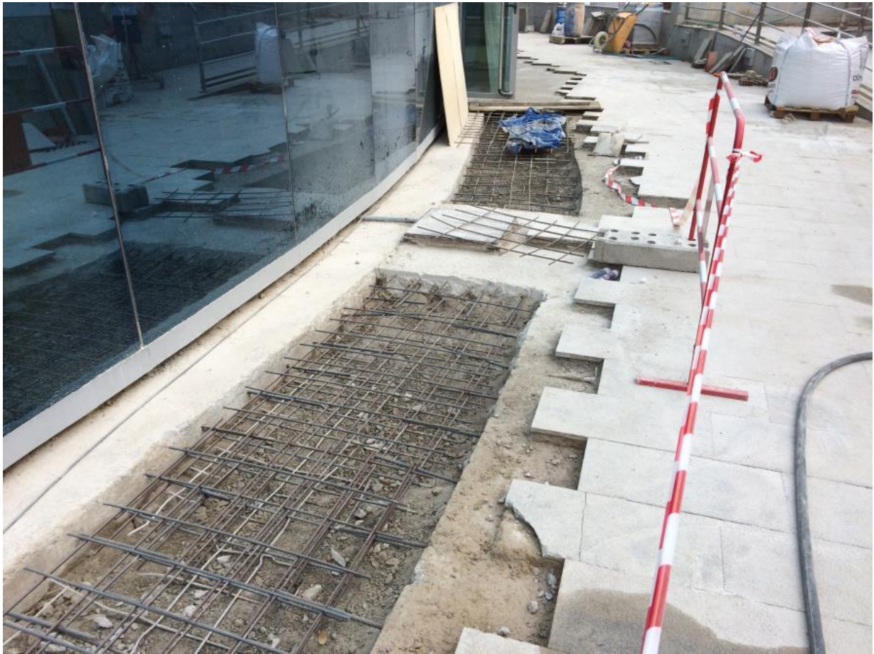
Colocación de la armadura de la losa de la zona de acceso al auditorio Mar Rojo.
