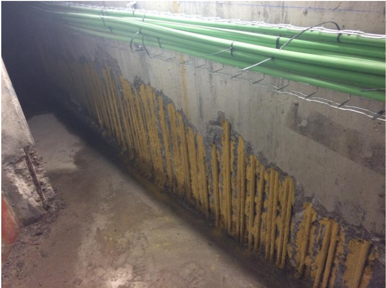
Tratamiento de pasivado a las armaduras que componen los muros de hormigón.
