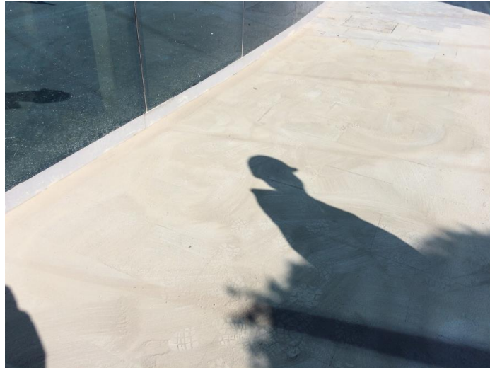
Figura 31. Pavimento terminado en zona exterior del auditorio Mar Rojo. 2017. Fuente: Fotografía tomada en obra. Martín Arcos, J. J.
