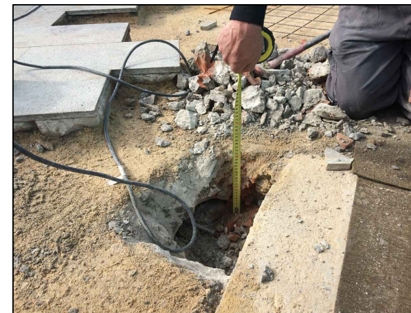
Espesor de solera existente (25 cm)
