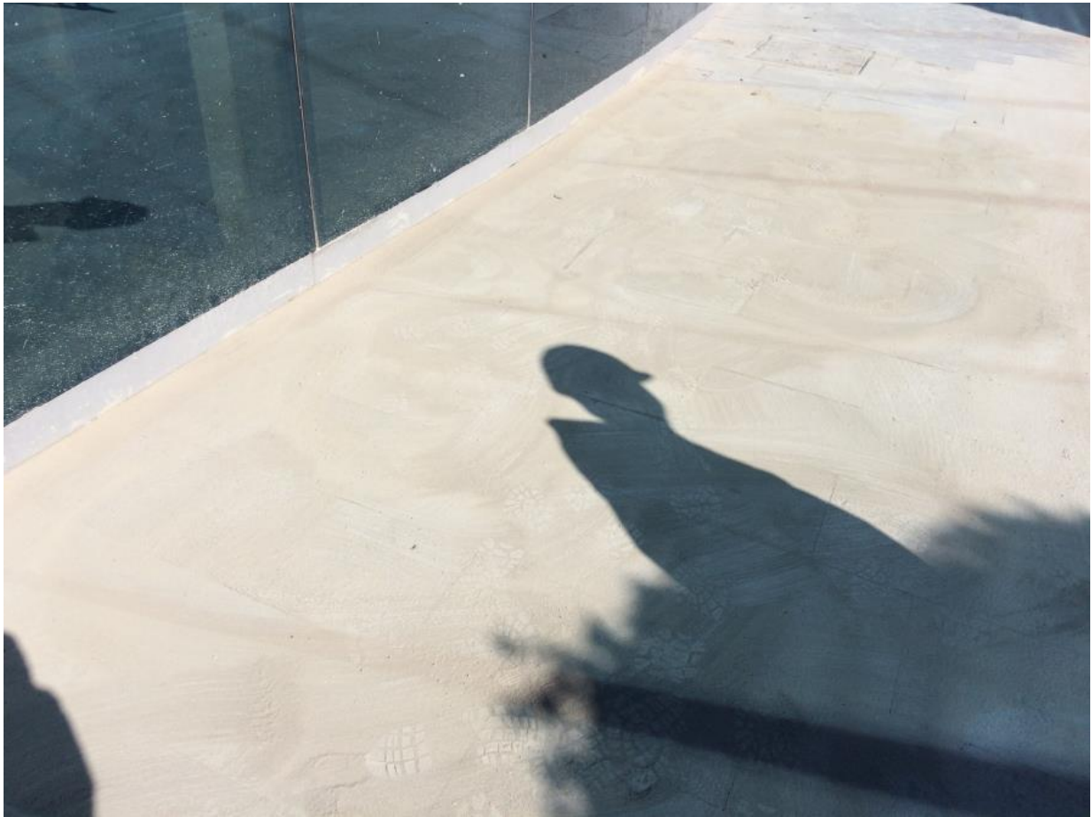
Pavimento terminado en la zona de acceso al auditorio Mar Rojo.
