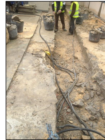
Zanja bajo solera encontrada tras el picado de la solera existente
