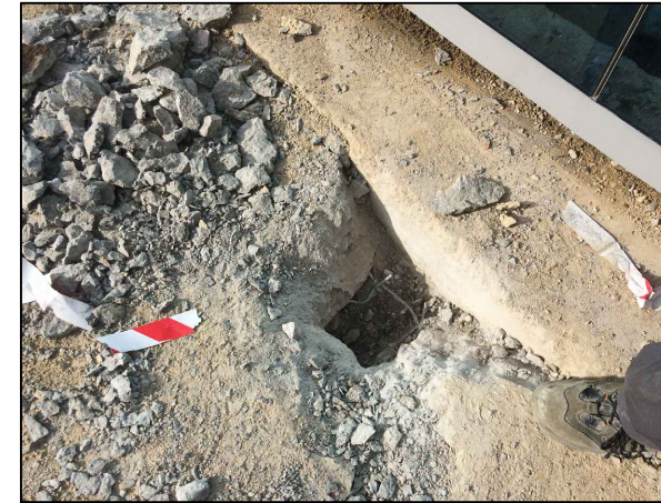
Mallazo apoyado en terreno bajo solera existente
