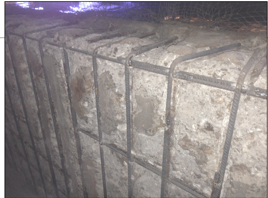
Fotografía tomada durante la comprobación del estado del acero.
