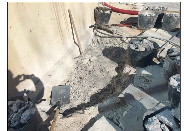
Picado de la solera existente.
