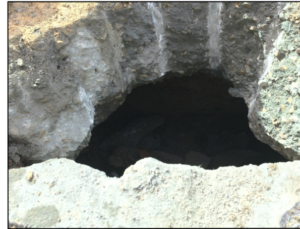
Zanja bajo solera encontrada tras realizar la cata
