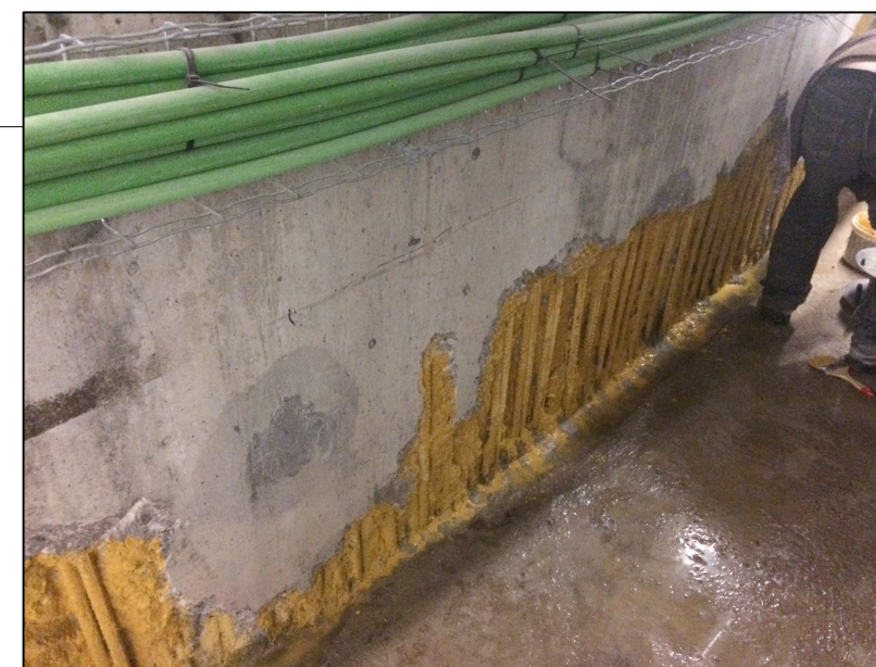
Fotografía tomada durante la aplicación de la base pasivadora y puente de unión mortero-acero y mortero-mortero
