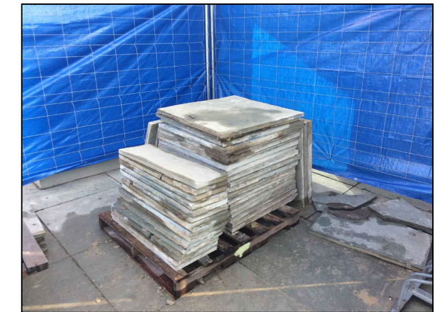
Piezas de pavimento recuperadas tras su retirada
