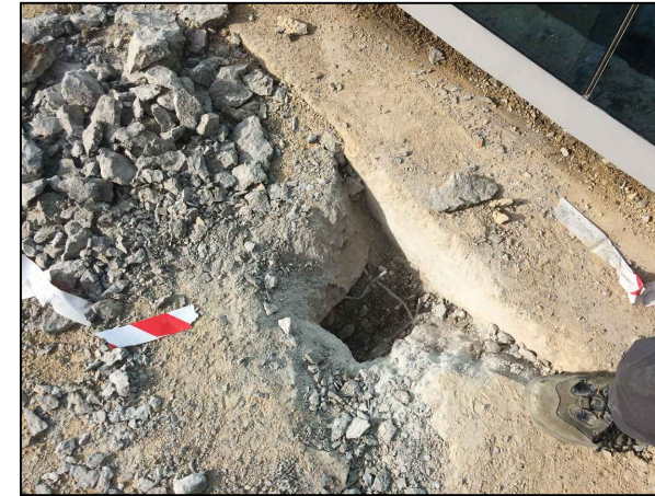
Mallazo apoyado en terreno bajo solera existente
