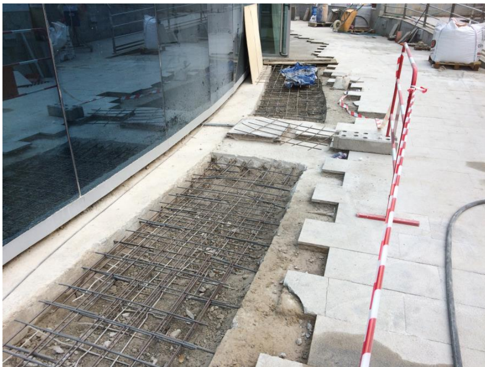
Figura 30. Colocación de acero y comienzo de hormigonado en zona exterior del auditorio Mar Rojo. 2017. Fuente: Fotografía tomada en obra. Martín Arcos, J. J.
