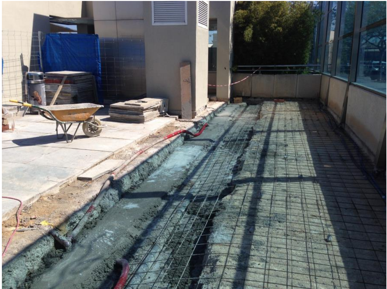
Colocación de armaduras en uno de los tramos de la Plaza de Acceso.
