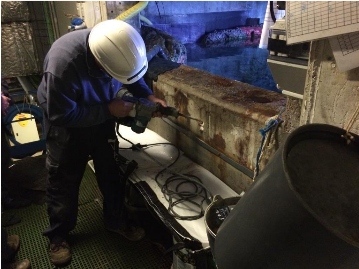
Realización de cata en paramento de hormigón objeto de la reparación.
