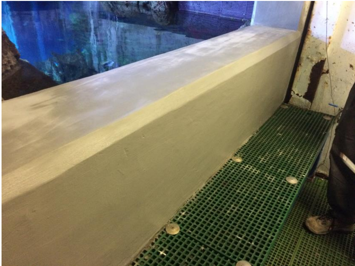
Acabado final tras la reparación.
