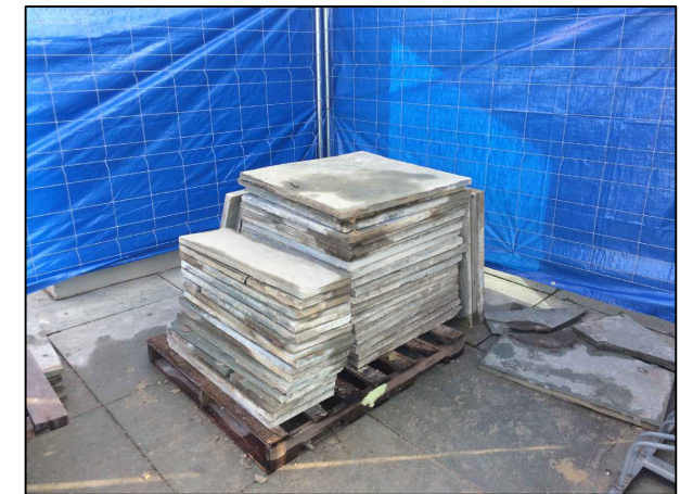
Piezas de pavimento recuperadas tras su retirada
