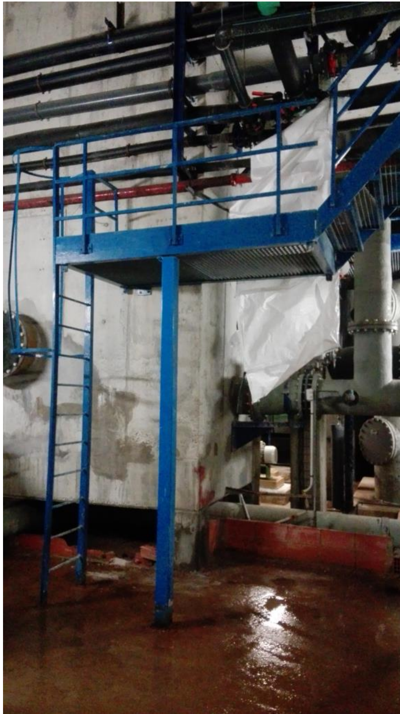
Escalera tratada en el interior.
