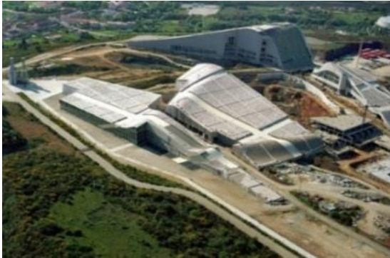
Ilustración 13: Obras de la Ciudad de la Cultura de Santiago
