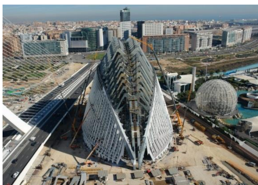
Ilustración 16: Obras el Ágora
