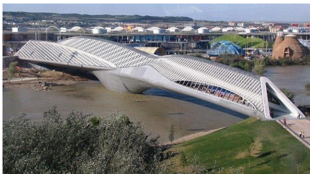
Ilustración 18: Pabellón Puente finalizado
