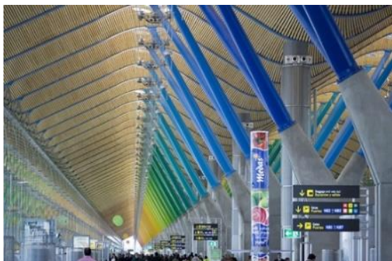
Ilustración 32: Interior T4 Madrid
