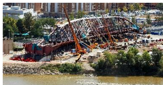
Ilustración 19: Obras Pabellón puente
