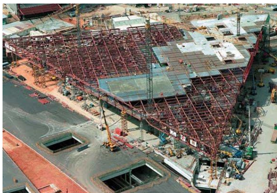
Ilustración 20: Obras edificio Fórum
