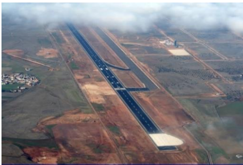
Ilustración 39: Pista aterrizaje aeropuerto Ciudad Real
