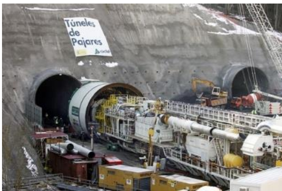
Ilustración 34: Variante de Pajares en obras
