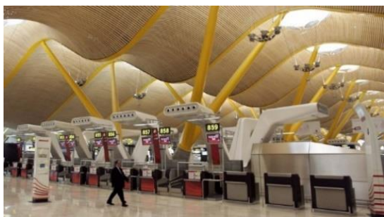
Ilustración 33: Interior T4 Madrid (2)
