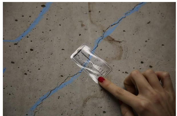
Figuras 30 y 31. Abertura de fisura en losa de canto 40 y muros interiores respectivamente.
