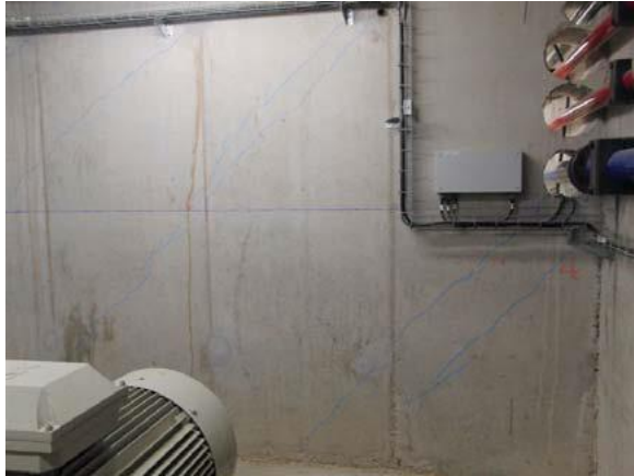
Figuras 17 y 18. Fisuras a 45º en sala de instalaciones y fisuras en zona central del muro interior (AICEQUIP, (2013)).
