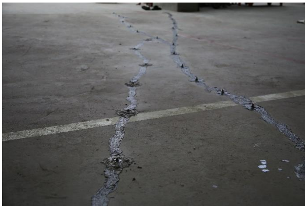
Figuras 71 y 72. Sellado de la superficie y resina empleada.
