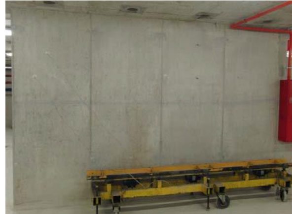
Figuras 17 y 18. Fisuras a 45º en sala de instalaciones y fisuras en zona central del muro interior (AICEQUIP, (2013)).
