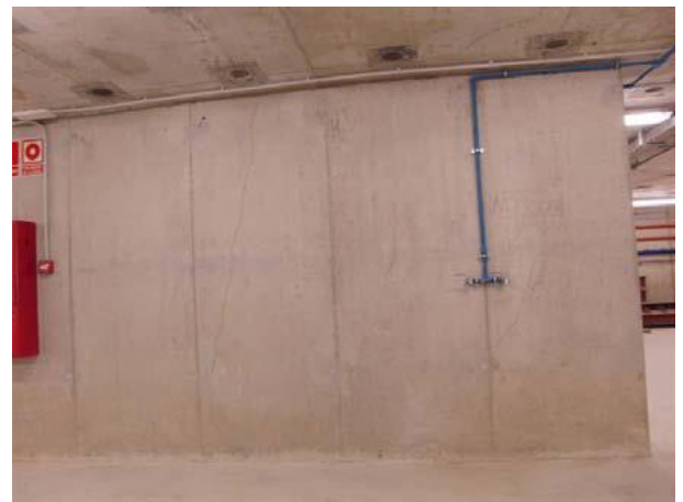
Figuras 13 y 14. Final de fisura en losa de 90 cm y fisuras en zona central de muro interior (AICEQUIP, (2013)).
