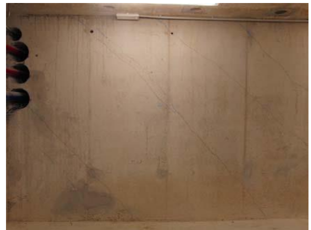
Figuras 19 y 20. Comprobación de abertura de fisura del día 25/01/2013 y Fisuración a 45º en el lado opuesto a la sala de instalaciones (AICEQUIP, (2013)).
