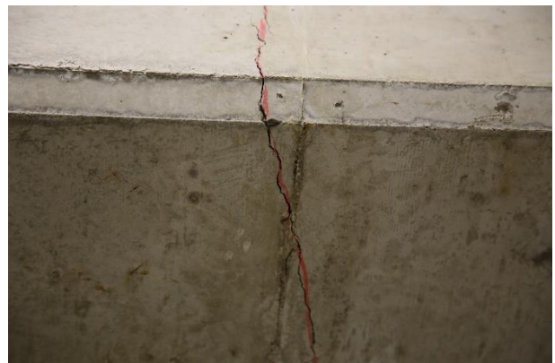
Figuras 26 y 27. Fisuración de la losa de canto 40 en su cara superior e inferior.
