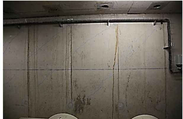
Figura 54. Fotografía de fisuras en muro interior de 35 cm de espesor (ambos extremos) en 2016.
