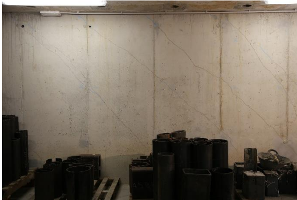
Figuras 28 y 29. Fisuración en muro interno en el extremo izquierdo y derecho.
