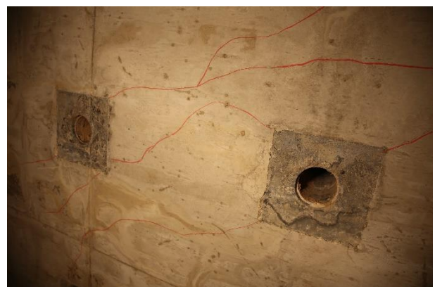
Figuras 32 y 33. Fisuración en losa de gran canto cara superior e inferior.
