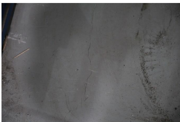
Figuras 32 y 33. Fisuración en losa de gran canto cara superior e inferior.
