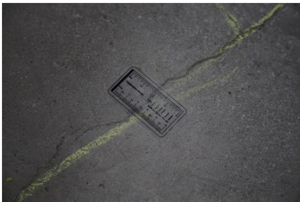
Figuras 30 y 31. Abertura de fisura en losa de canto 40 y muros interiores respectivamente.
