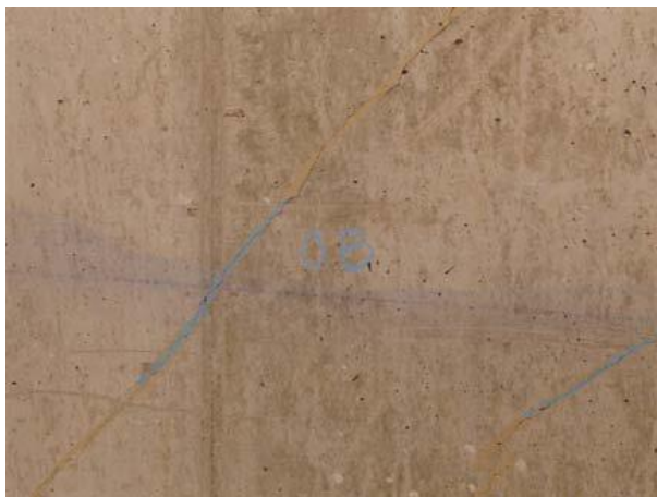
Figuras 15 y 16. Evolución de fisura en losa de 40 cm y fisuras a 45° en muro interior (AICEQUIP, (2013)).
