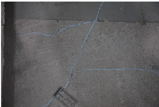
Figuras 26 y 27. Fisuración de la losa de canto 40 en su cara superior e inferior.
