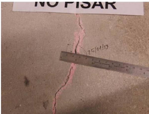
Figuras 19 y 20. Comprobación de abertura de fisura del día 25/01/2013 y Fisuración a 45º en el lado opuesto a la sala de instalaciones (AICEQUIP, (2013)).
