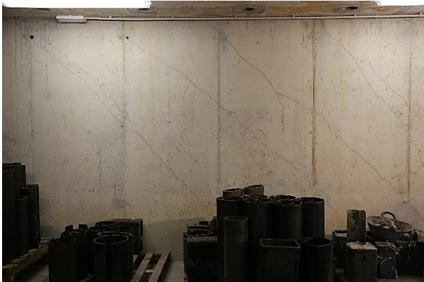
Figura 54. Fotografía de fisuras en muro interior de 35 cm de espesor (ambos extremos) en 2016.
