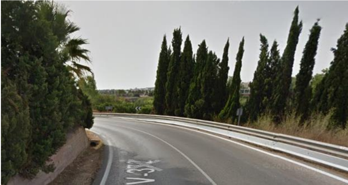
Imagen 9. Paso salvacunetas en la margen izquierda. PK 4+200.
