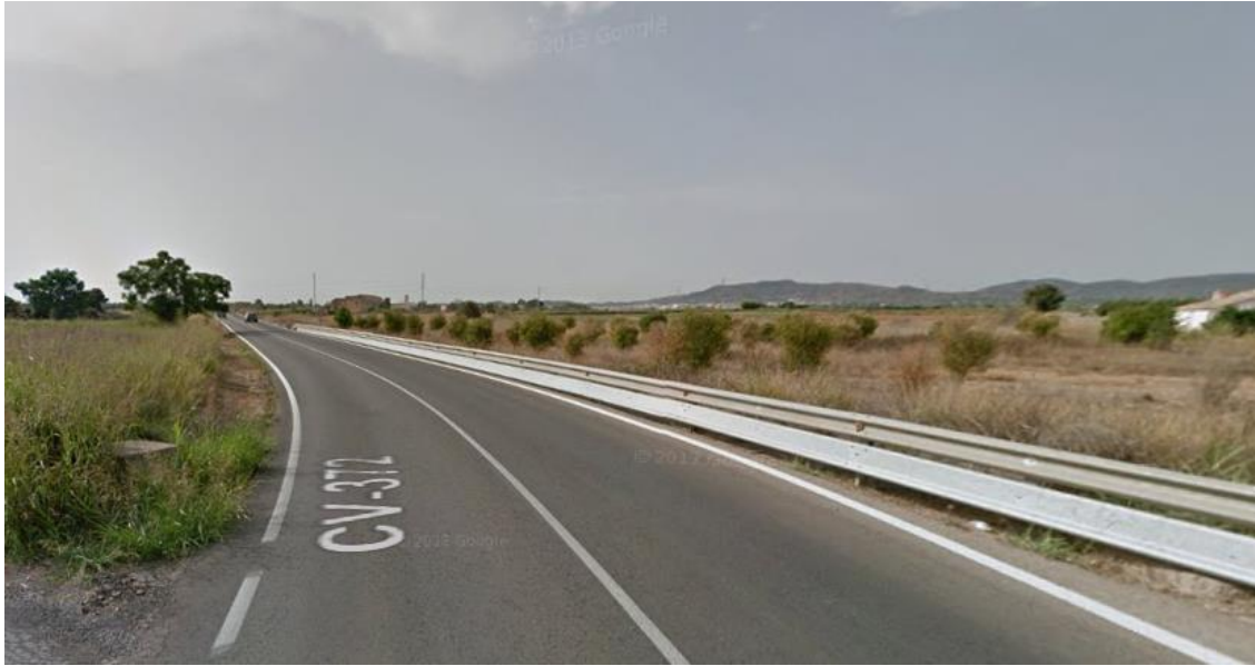
Imagen 5. Calzada en el PK 1+800
