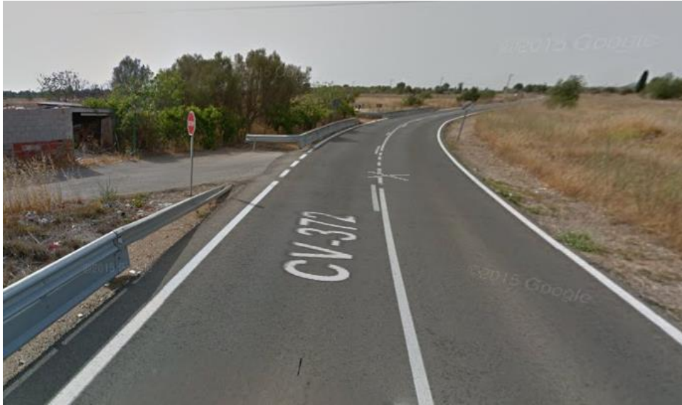
Imagen 20. Accesos PK 1+500. Vista en superficie
