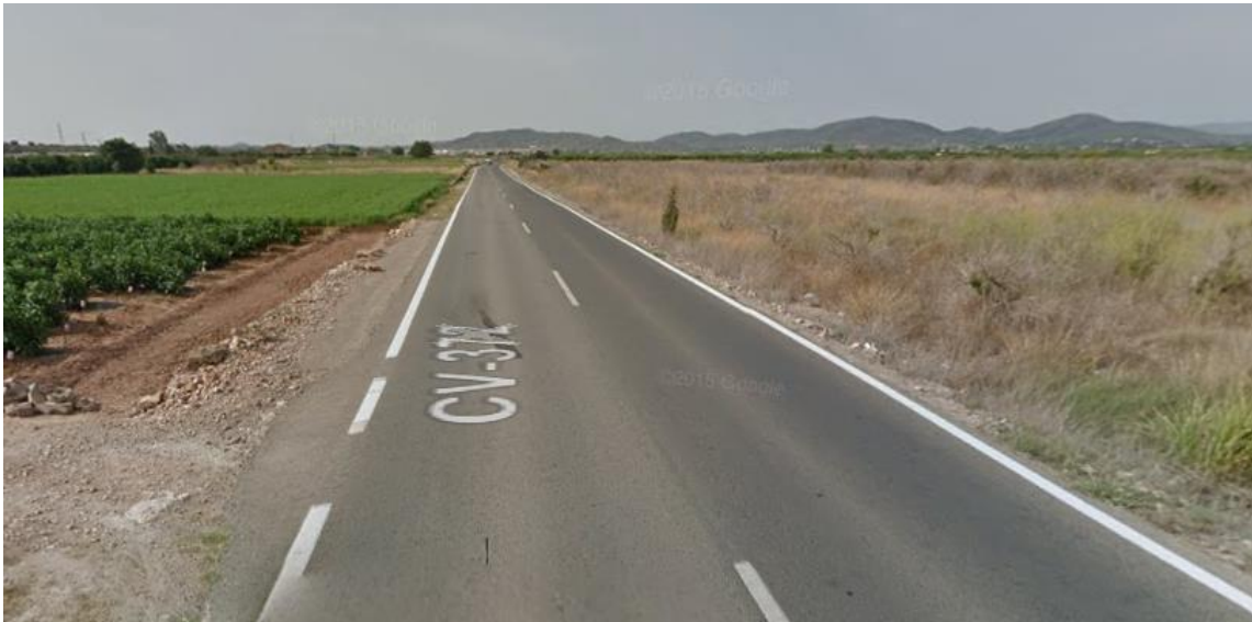
Imagen 3. Calzada en el PK 0+800
