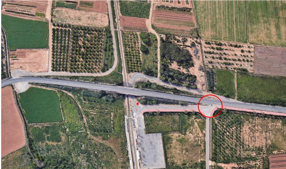
Imagen 76. Acceso inicio del paso superior. Vista aérea.
