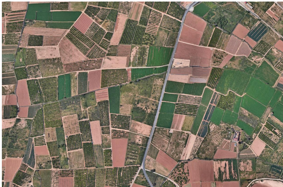
Imagen 79. Accesos tramo entre los PK 0+640 y 1+130. Vista aérea
