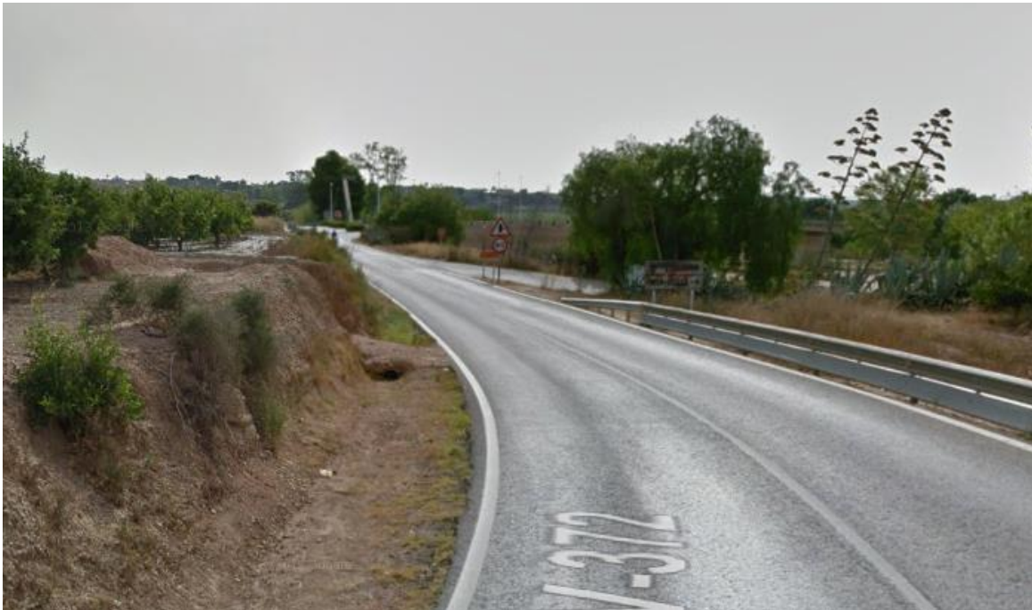
Imagen 10. Paso salvacuneta en la margen izquierda. PK 4+300.
