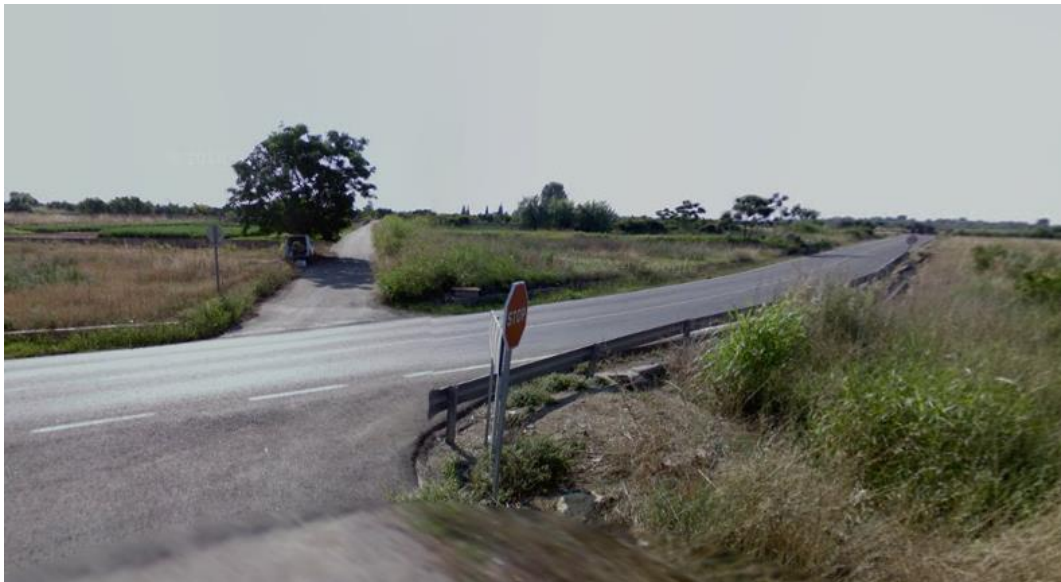
Imagen 17. Acceso PK 1+200 margen derecha. Vista en superficie
