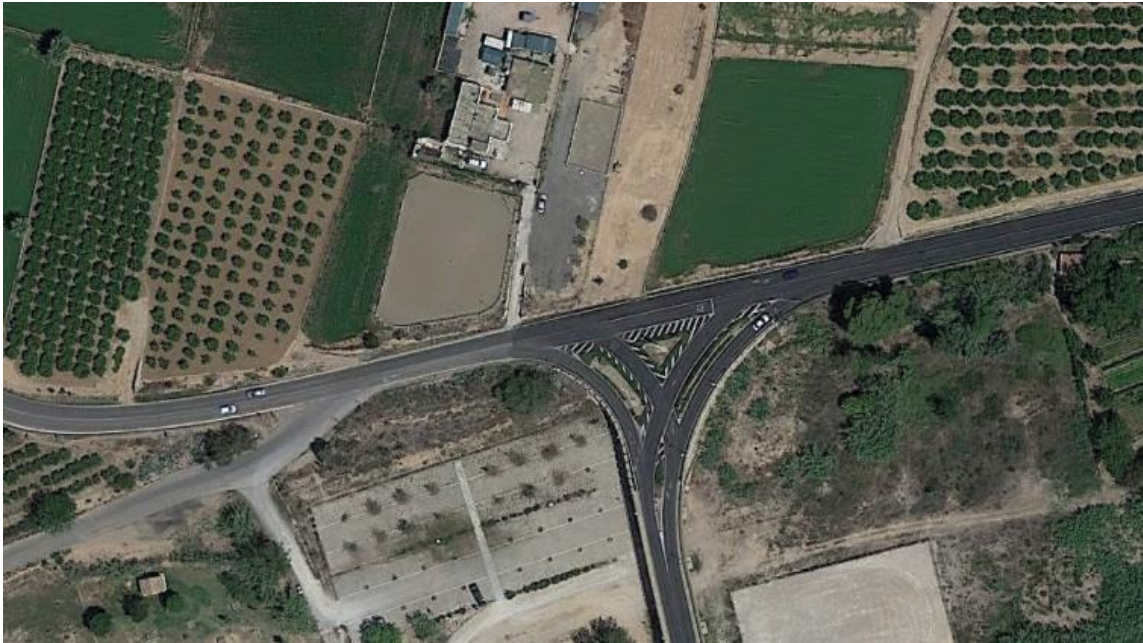
Imagen 26. Accesos entre los PK 4+300 e intersección final del recorrido Vista aérea
