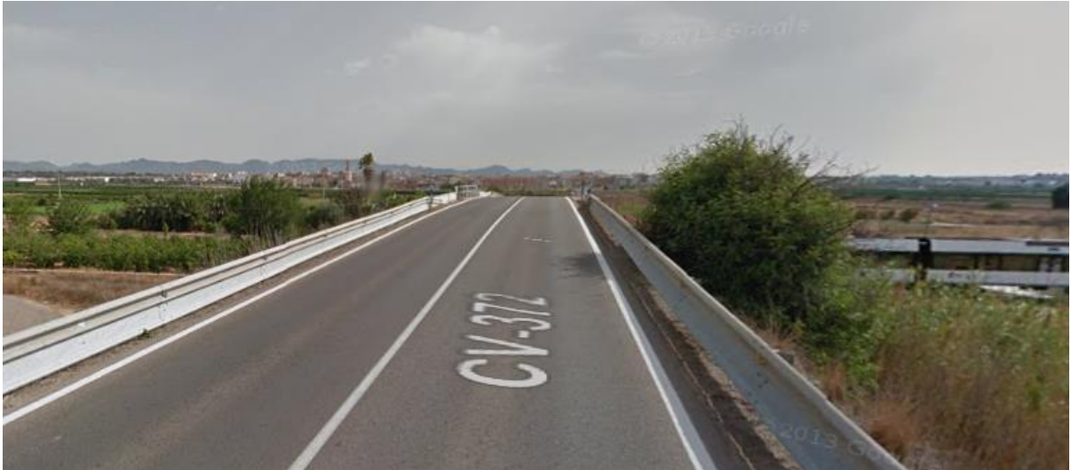
Imagen 41. Cambio de rasante en el paso superior
