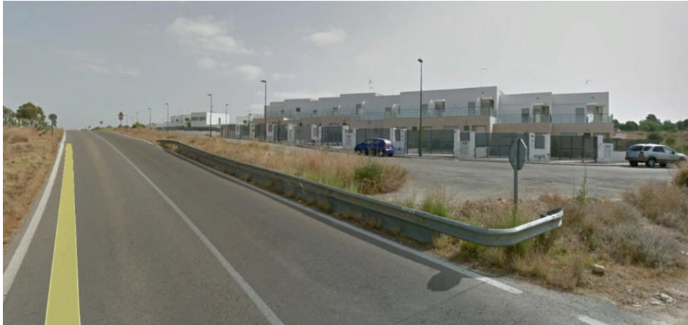
Imagen 95. Acceso PK 3+420. Vista en superficie
