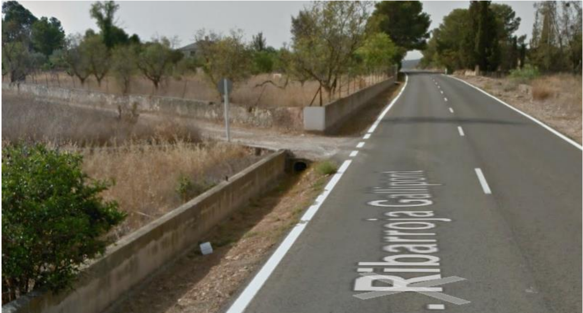
Imagen 7. Paso salvacuneta en la margen izquierda. PK 2+200.
