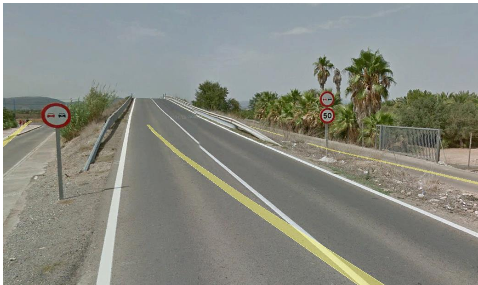
Imagen 77. Acceso inicio del paso superior. Vista en superficie.
