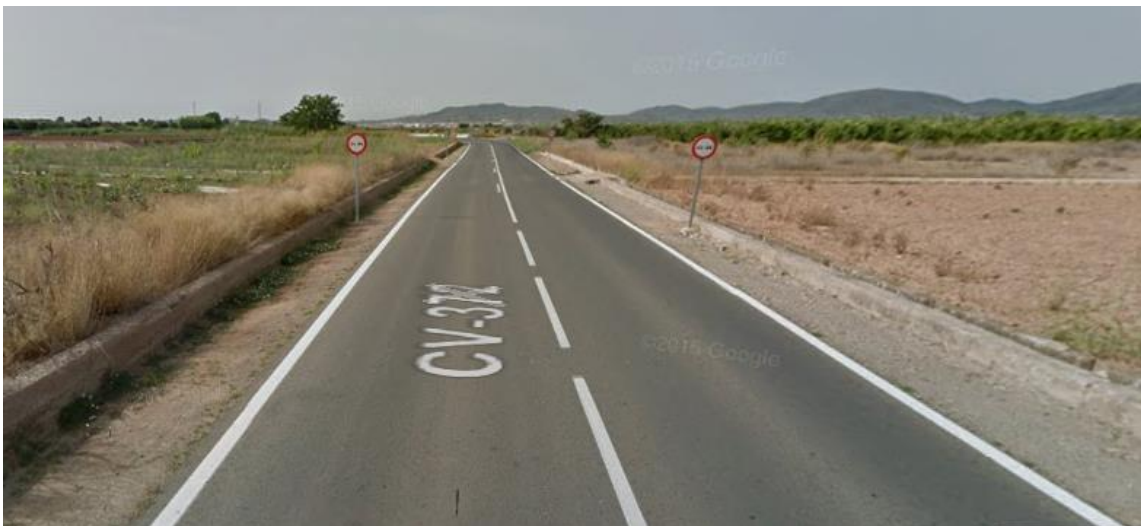
Imagen 4. Calzada en el PK 1+100
