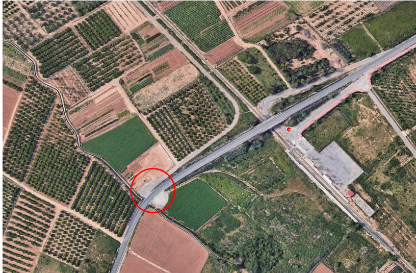
Imagen 78. Acceso final del paso superior. Vista aérea
