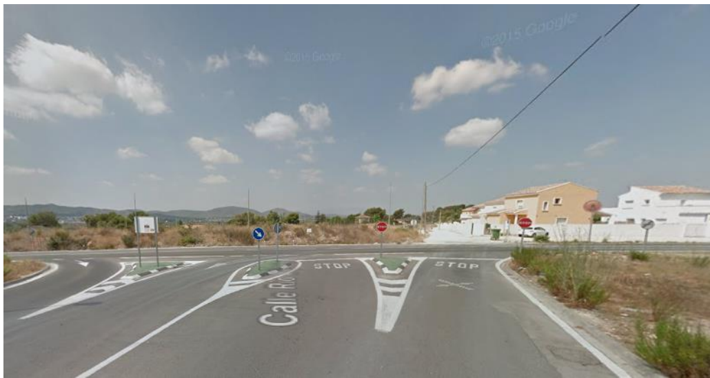
Imagen 23. Intersección canalizada en el PK 2+700. Vista en superficie
