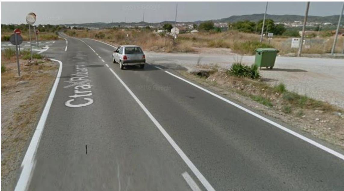
Imagen 8. Cuneta sobredimensionada y paso en la margen derecha. PK 2+700.
