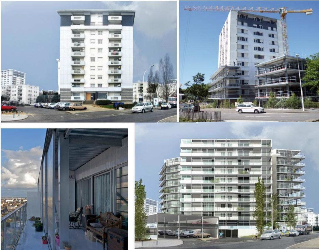
Fig. 6 Fotos del estado original del edificio, el proceso constructivo de las adiciones y del resultado final.
