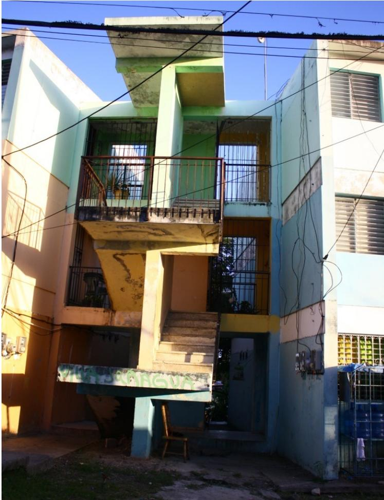
Fig. 18 Estado actual del acceso a dos bloques de edificios de apartamentos del sector Las Caobas en Santo Domingo Oeste, en el que se construyeron 1,375 viviendas, entre apartamentos y casa unifamiliares, a finales de la década de los 70. La imagen evidencia el pésimo estado de conservación de las zonas comunes de los edificios. Fuente: propia.
