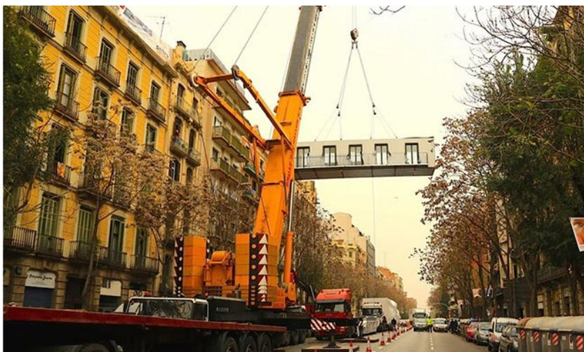
Fig. 28 Imagen del proceso constructivo de una vivienda de La Casa sobre el tejado en el momento en el que una grúa eleva uno de los módulos prefabricados de la vivienda. Luego de ser colocado en su posición final se iniciarán las labores de terminación y conexión de instalaciones
