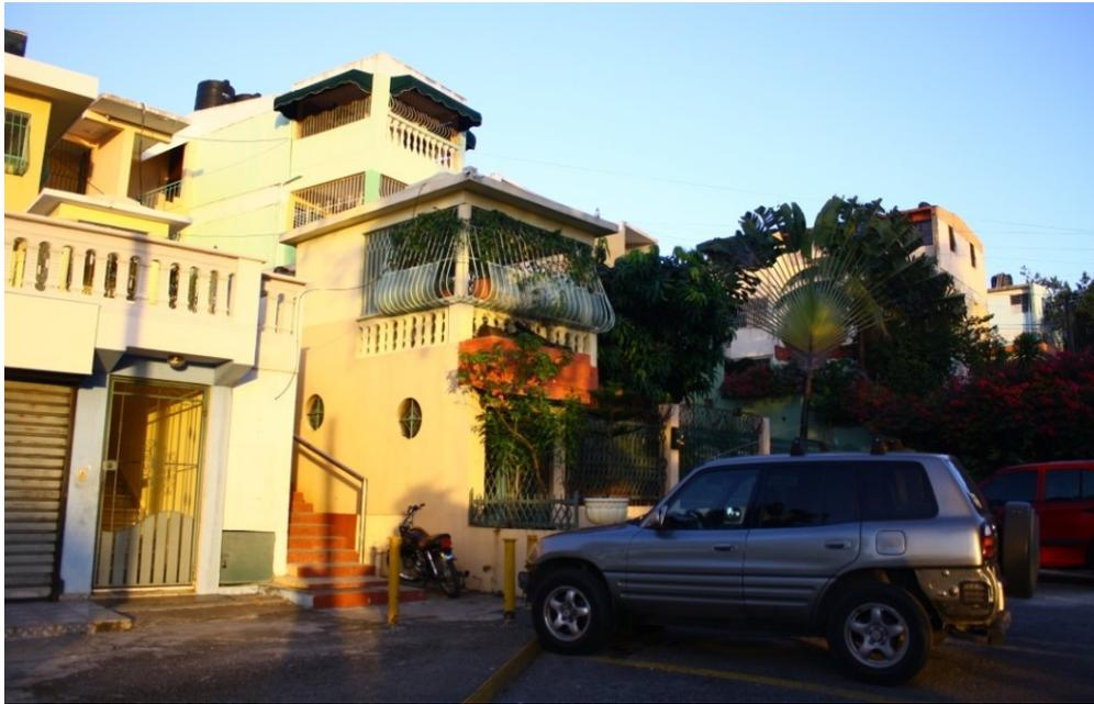
Fig. 8 Fotografía de un edificio del sector Las Caobas que muestra el estado actual de un bloque multifamiliar y su transformación luego de la sucesiva adición de nuevas construcciones entre terrazas y otros espacios complementarios. Ninguno de los balcones de la fotografía formaban parte del edificio original. Además se han construido locales comerciales y nuevas escaleras de acceso. La fachada original se encuentra a más de 10 metros del nuevo frente.
