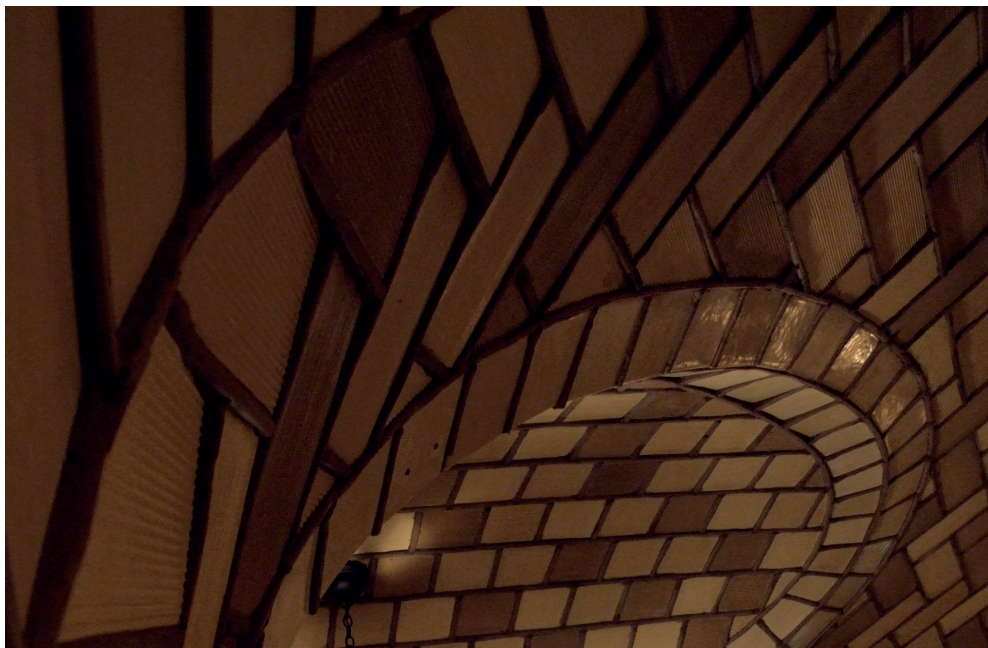
1. Vista de una de las bóvedas de Guastavino en el Oyster Bar de Nueva York (foto: Fernando Vegas y Camilla Mileto)
