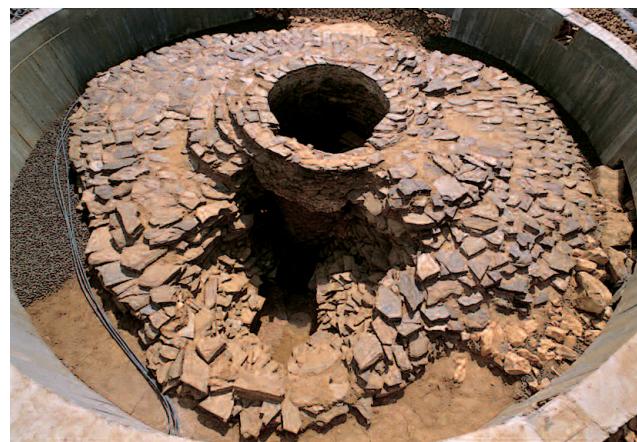
2. La subestructura del túmulo durante la restauración
