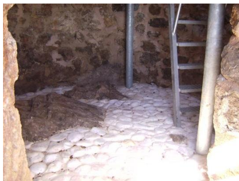
Fig. 6.- Detalle del nuevo pavimento de canto rodado del interior de la Torre. (P.E. Collado)
