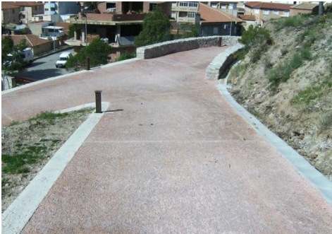
Fig.9.- Detalle de camino terminado con zona encuentro y descanso al fondo. (P.E. Collado)
