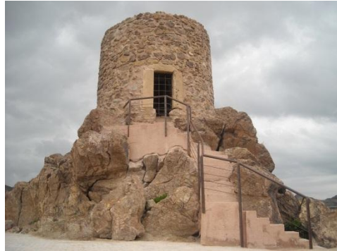
Fig. 13.- Imagen de la Torre del Molinete después de la restauración. (P.E. Collado)
