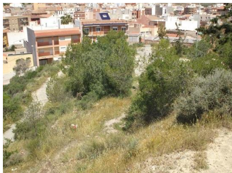
Fig. 3.- Detalle de la ladera del Cerro antes de la intervención. (P.E. Collado)
