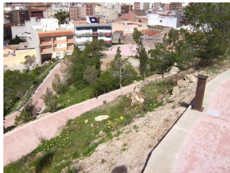
Fig.10.- Detalle de la ladera del Cerro después de la intervención. (P.E. Collado)
