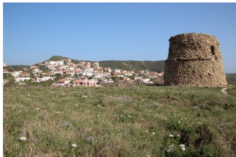
Fig. 3- Torre del Pozzo restored
