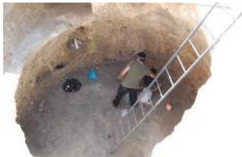
Fig.8- Il silos durante i lavori di consolidamento.
