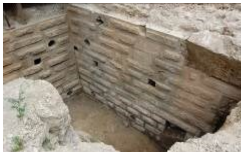
Fig. 5- Le bocche da fuoco che permettono il tiro di fiancheggiamento.
